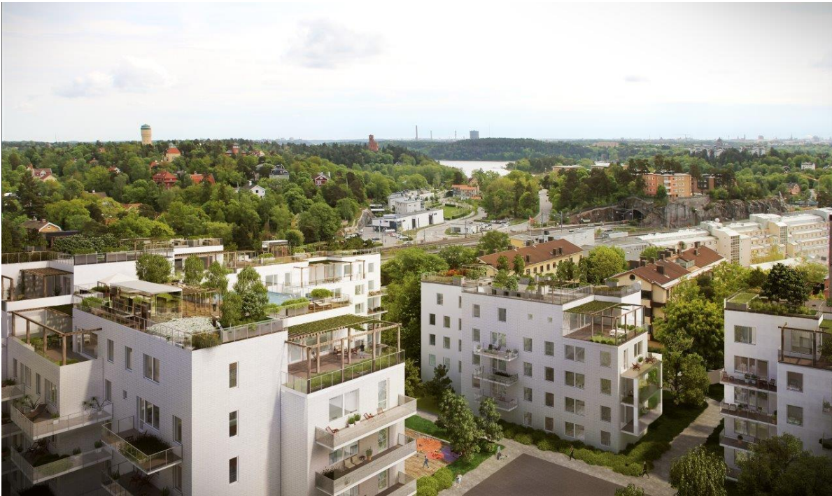
Utsikt mot sydost från befintliga flerbostadshuset på fastigheten Sjukhuset 17, Mörbylund 7-15. Illustration från Ettelva Arkitekter.
