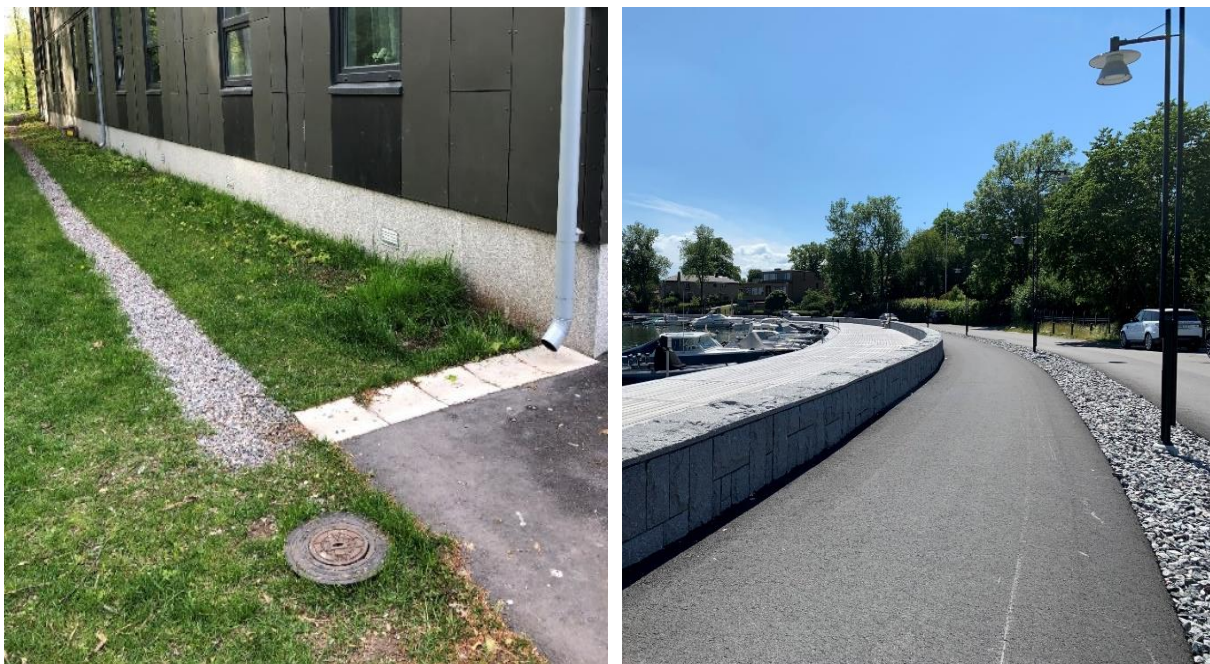
Figur 21. Makadamdiken kan anläggas både på kvartermark samt allmän platsmark. T.V. visas fördrojning av takvatten från ett flerbilshus i Stockholm (Foto: Bjerking). T.H. är ett makadamdike mellan väg och gång- och cykelbana i Samsjövik i Danderyds östra delar (Foto: Danderyds kommun).
