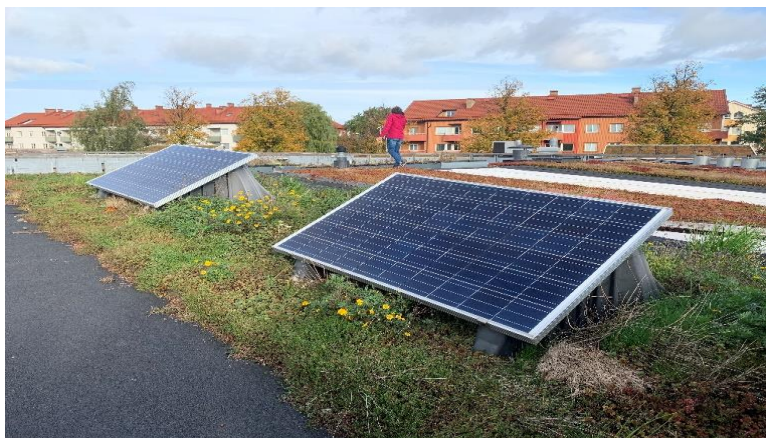
Figur 22. Vegetationsklädda tak, eller så kallade gröna tak, kan anläggas på hustak och komplementbyggnader så som exempelvis sophus och taklagda cykelställ. Exempelbilder från Stockholm och Malmö (Foton: Bjerking)
