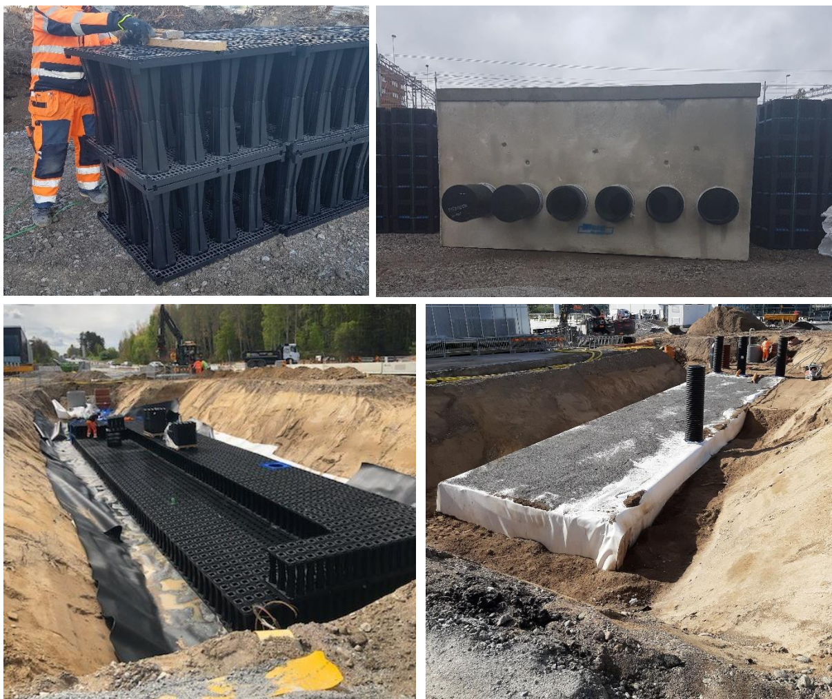
Figur 29. Underjordiska magasin som detta kassettmagasin i Järfalla (uppe) och Sollentuna (nere) kan användas i områden där ytor för anläggningar i marknivå saknas. (Foto: Bjerking).
