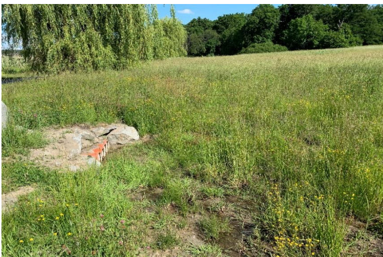
Figur 26. Vid Sättra ängar i Danderyd har en dagvattenledning öppnats upp. Vattnet tillåts nu sila över en större grönyta innan utsläpp till Edsviken (Foto: Bjerking).
