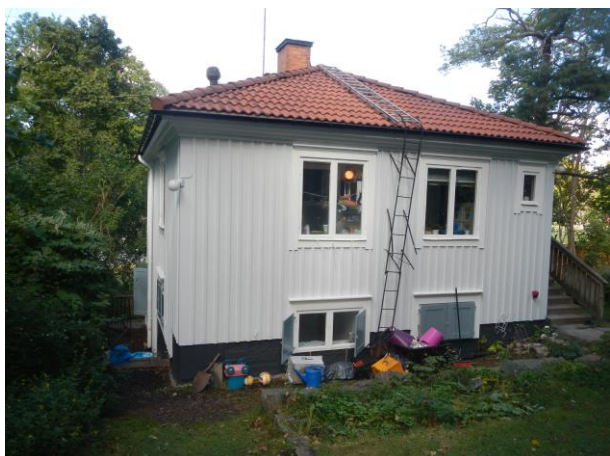
Bild 2 visar baksida av byggnaden.
