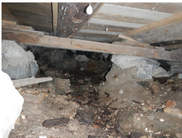
Bild 3 visar interiör från krypgrund under kök.
