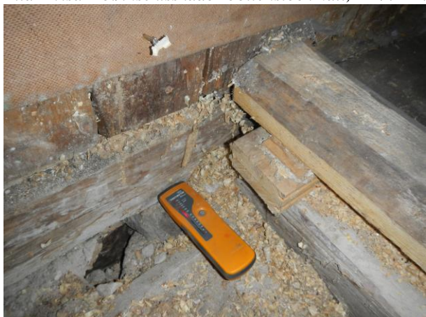
Bild 6 visar bristande fuktskydd timmer, 30 % FK.
