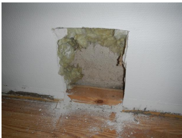
Bild 13 visar konstruktionsingrepp i motfylld källaryttervägg.
