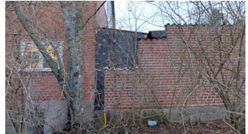
Befintlig senare tillkommen förrådsbyggnad mot huvudbyggnad som från gaturummet liknar en mur. Ansluter indet direkt mot huvudbyggnaden utan har en tillfälligt uppförd slussdel av skivmaterial.
