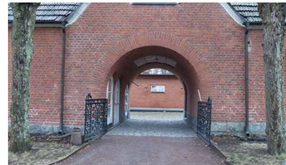
Sjövillans genomgående portgång som från början användes för hästskjutsar till stallet på gården blir i förslaget igensatt med ett glasparti en bit in i portgenomgången. Den nya gymbyggnadens naturstensfasad bildar ny fond bakom glaspartiet.
