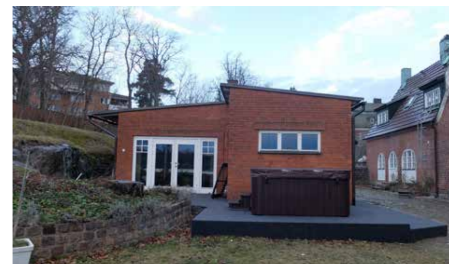
Gymbyggnaden med framförvarande bubbelpool och rabatt.
