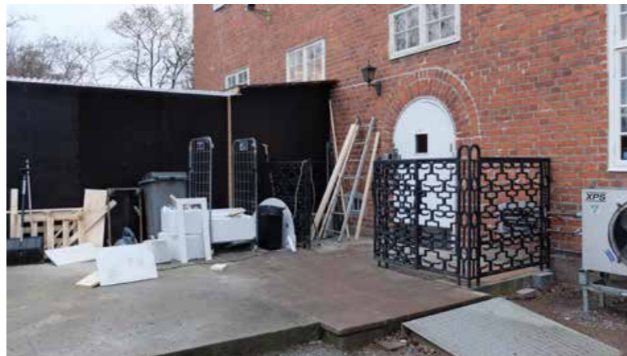
Ursprunglig köksentré med anslutande dekorativt smidesräcke som är tänkt att flyttas något för att möjliggöra en mer tillgänglig entrédel.
