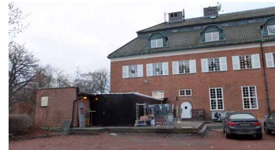
Huvudbyggnaden från nord med ursprunglig köksentré till höger om tegelmurat sopuset och senare tillägg. Den föreslagna tillbyggnaden innebär en renodling av gårdsmiljön som är till fördel för upplevelsen av fastigheten i sin helhet.
