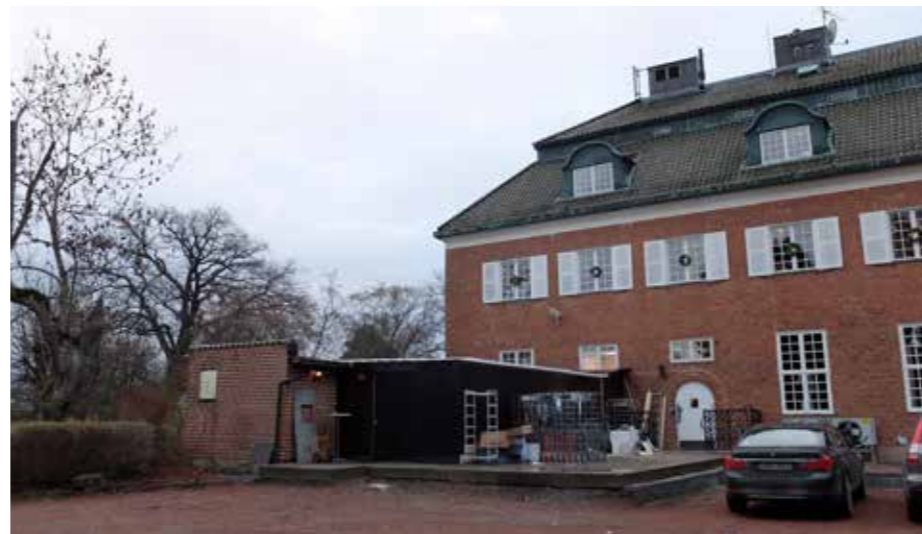
Befintligt förråd i tegel vid huvudbyggnad med ytterligare tillfälligt förråd i svart skivmaterial som står på anslutande större betongplatta.
