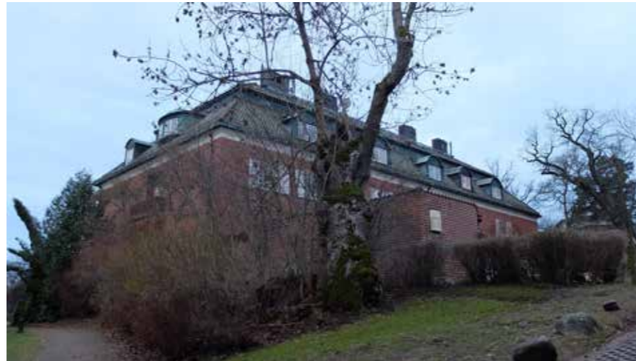
Huvudbyggnaden från nordöst med det tillbyggda sopuset som skymtar fram bakom det karaktärsgivande trädet av hög ålder. Trädet står i farozonen för en eventuell nybyggnad och bör med hänsyn till dess höga ålder och biologiska värden om möjligt värnas.
