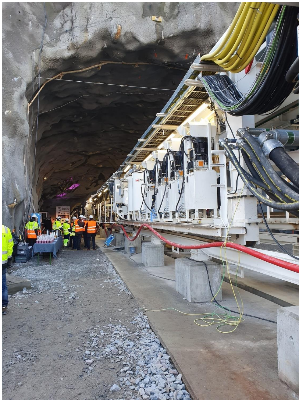
Bild ovan: Kraftledningstunnel.
