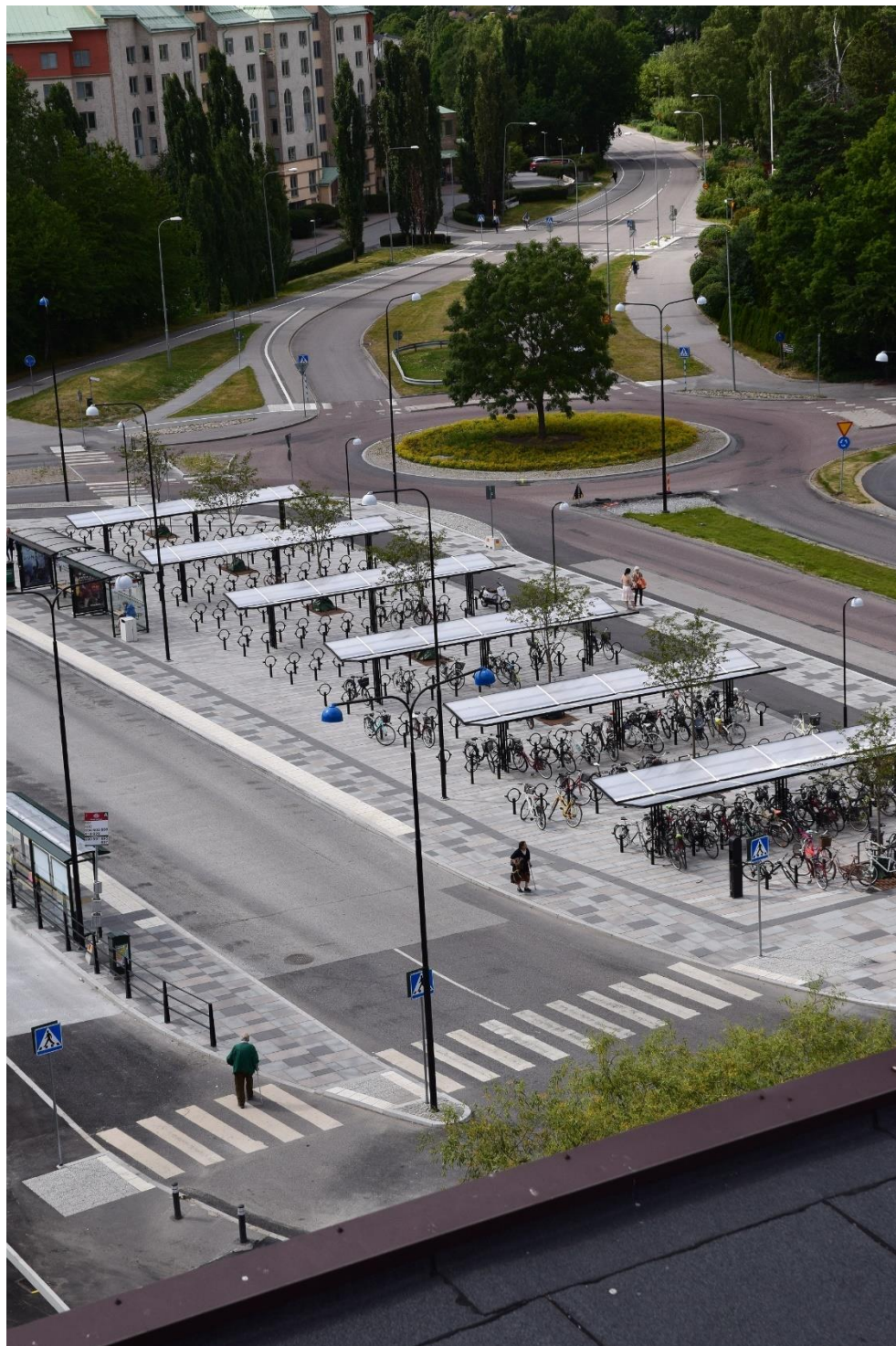
Bild ovan: Cykelparkering - Mörby Centrum.
