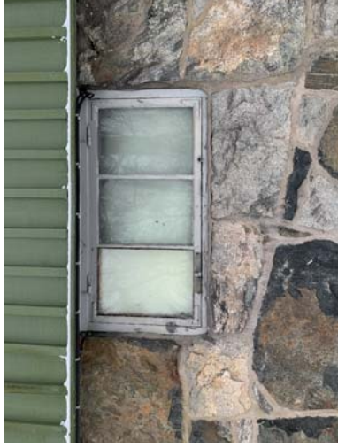
Skolan 12. Ursprungligt källarfönster.
