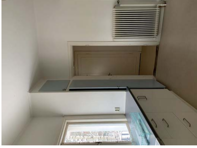
Skolan 11. Kök med ursprungliga fönstersnickerier, dörrfoder och radiator. Sekundära köksskåp.
