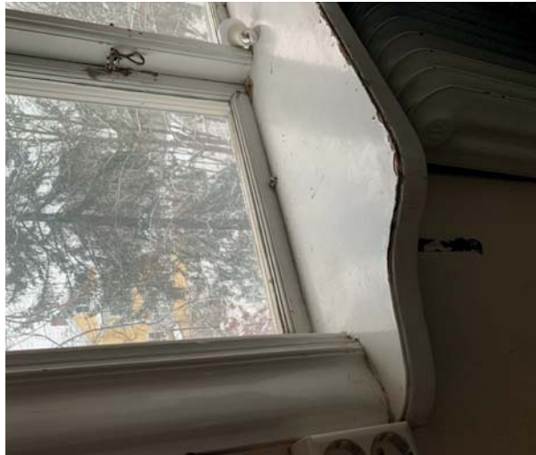
Skolan 12. Ursprungliga fönstersnickrier i trapphuset.
