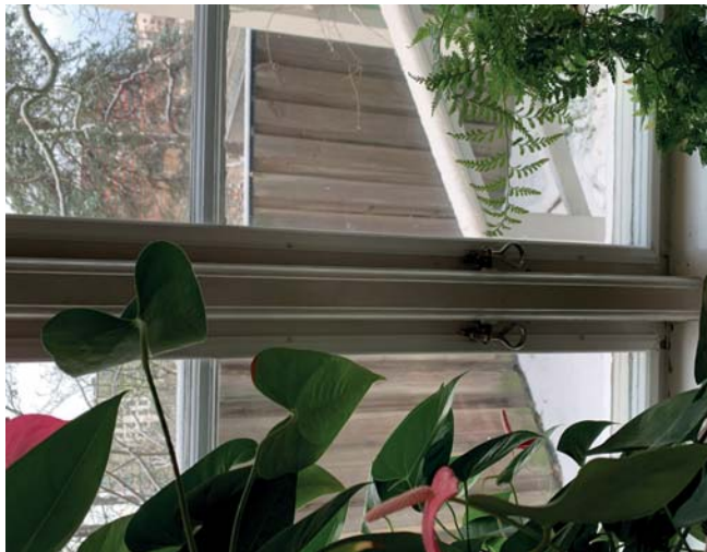
Skolan 12. Ursprungliga fönster med tillagd ljudisoleringsruta mot Norrtäljevägen och Roslagsbanan.
