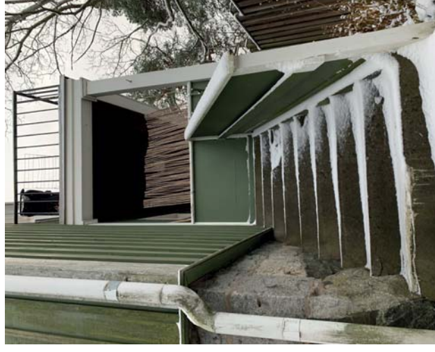
Skolan 12. Ursprungliga trappan till den västra bostaden igensatt med räcke i masonit.
