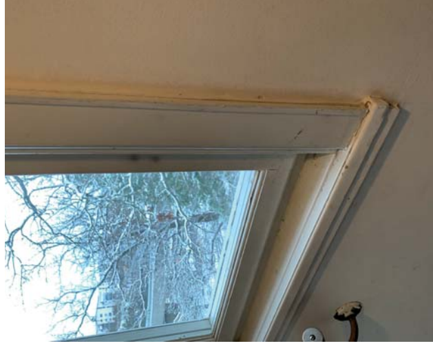
Skolan 11. Fönsterfoder med enkla profiler och fönsterbänk.
