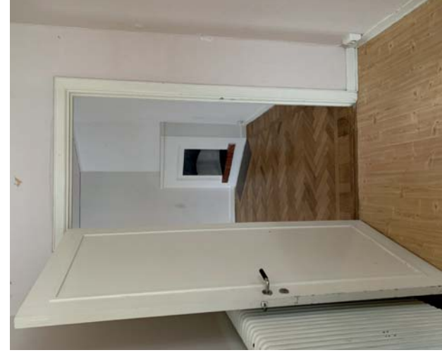
Skolan 11. Vy från hallen till vardagsrummet. Foder med enkla profiler, dörrar med fyllning i ram och beslag med handtag i bakelit.
