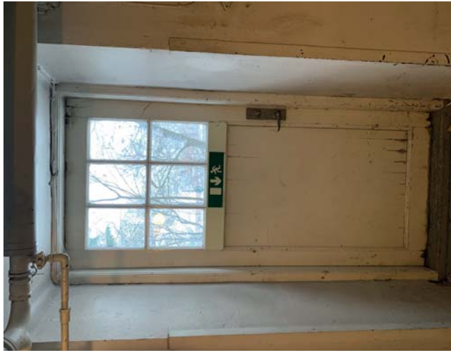
Skolan 12. Ursprunglig ytterdörr till källaren.
