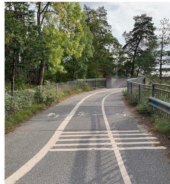
Gång- och cykelbron över Roslagsbanan och motorvägen.
