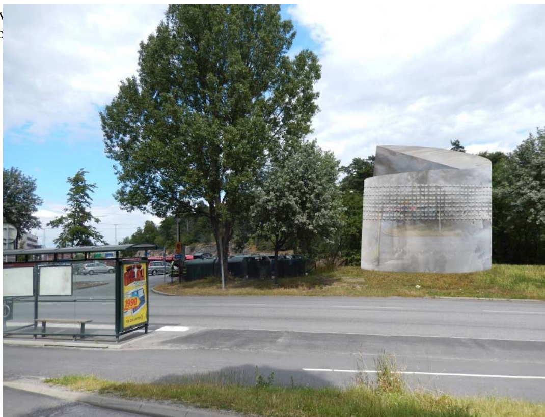
Ventilationshuv med fasad av rostfri plåt i Mörby
