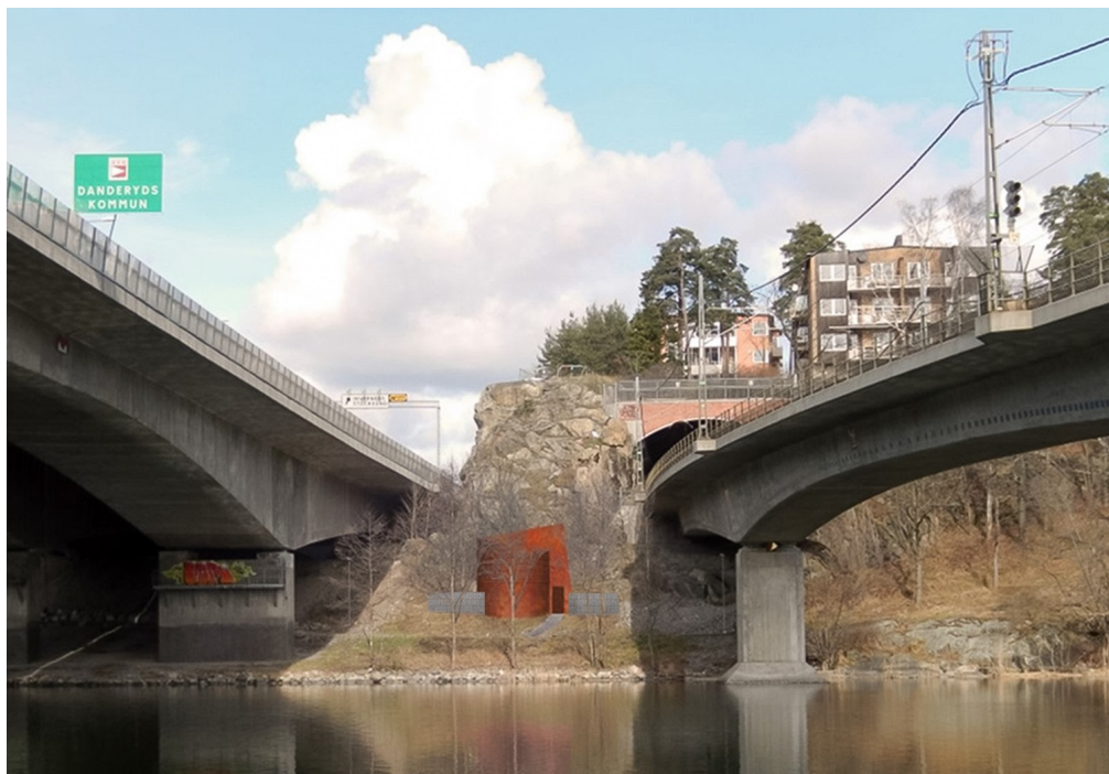
Ventilationsschakt och huvud vid Stocksundet
