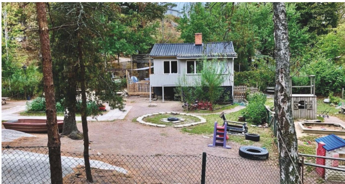
Foto från Ejderstigen med vy över den aktuella fastigheten.
