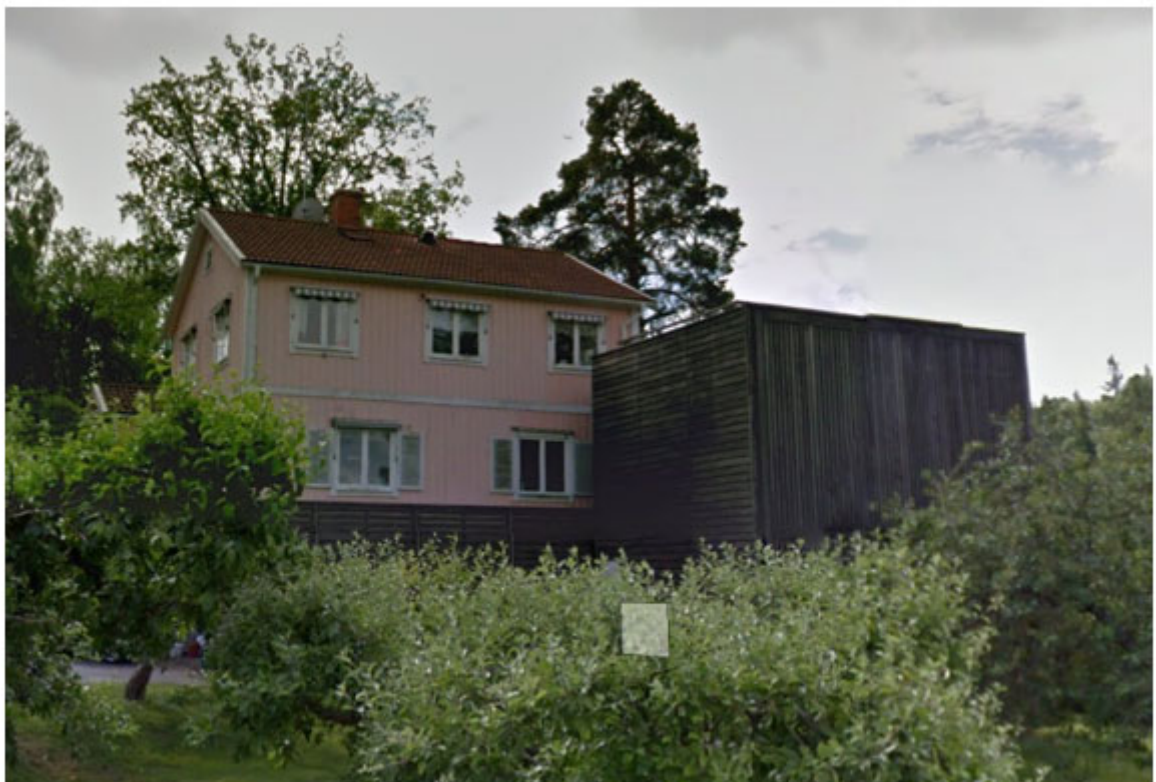
Bildtext: Huvudbyggnaden i nuvarande utseende med tillbyggnaden från 1998. Bild från 2011.
