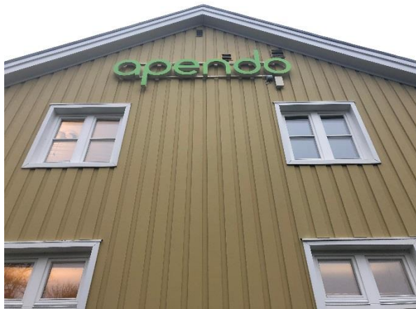
Tilläggsisolering med gul fasadplåt.
