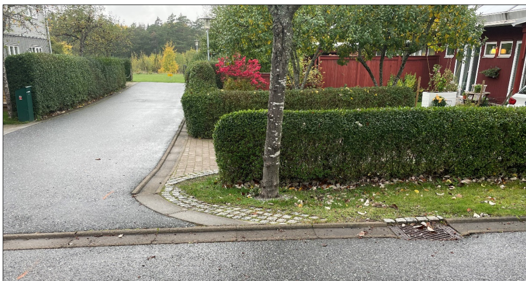
Figur 5. Tvärgata i riktning västerut. Notera rännalsplattor längs med huvudgata till brunn, FOTO Charlotte Mjällby
