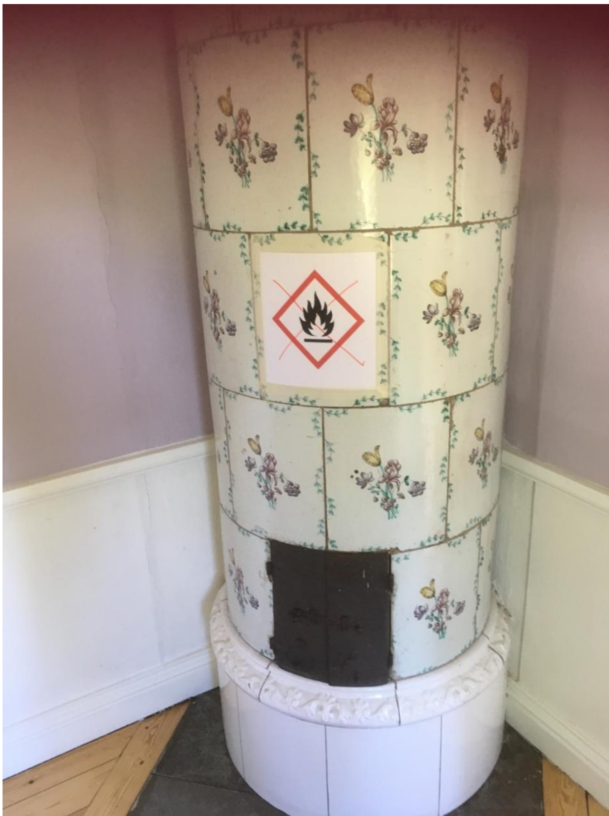
En kakelugn i ett av sovrummen, plomberad för tidigare barnverksamhet.
