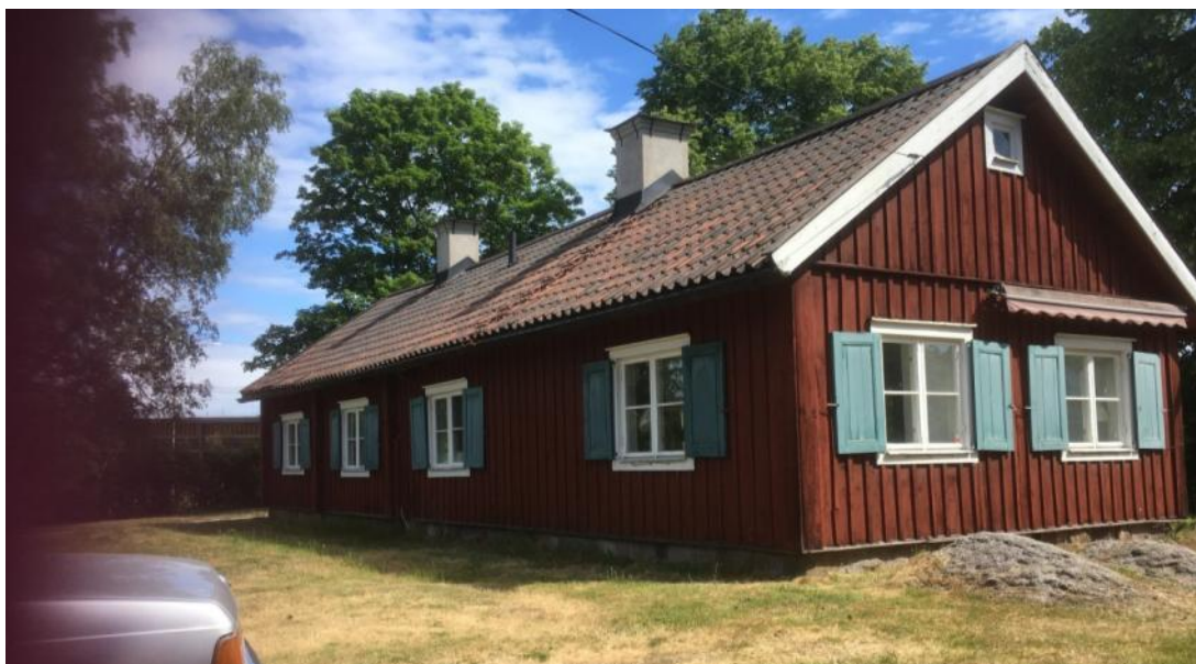
Huvudbyggnaden från sydväst.
