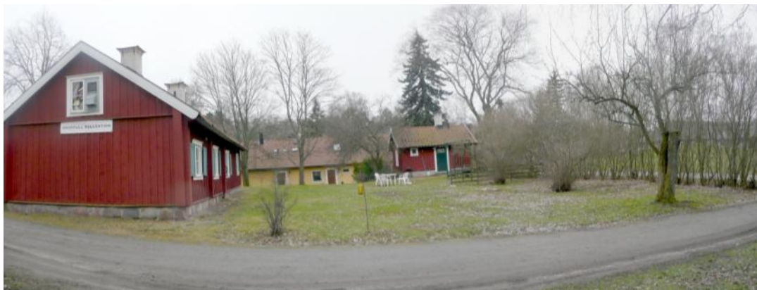
Huvudbyggnaden till vänster, torpet till höger och radhusen i fonden. Fotot taget från norr.
