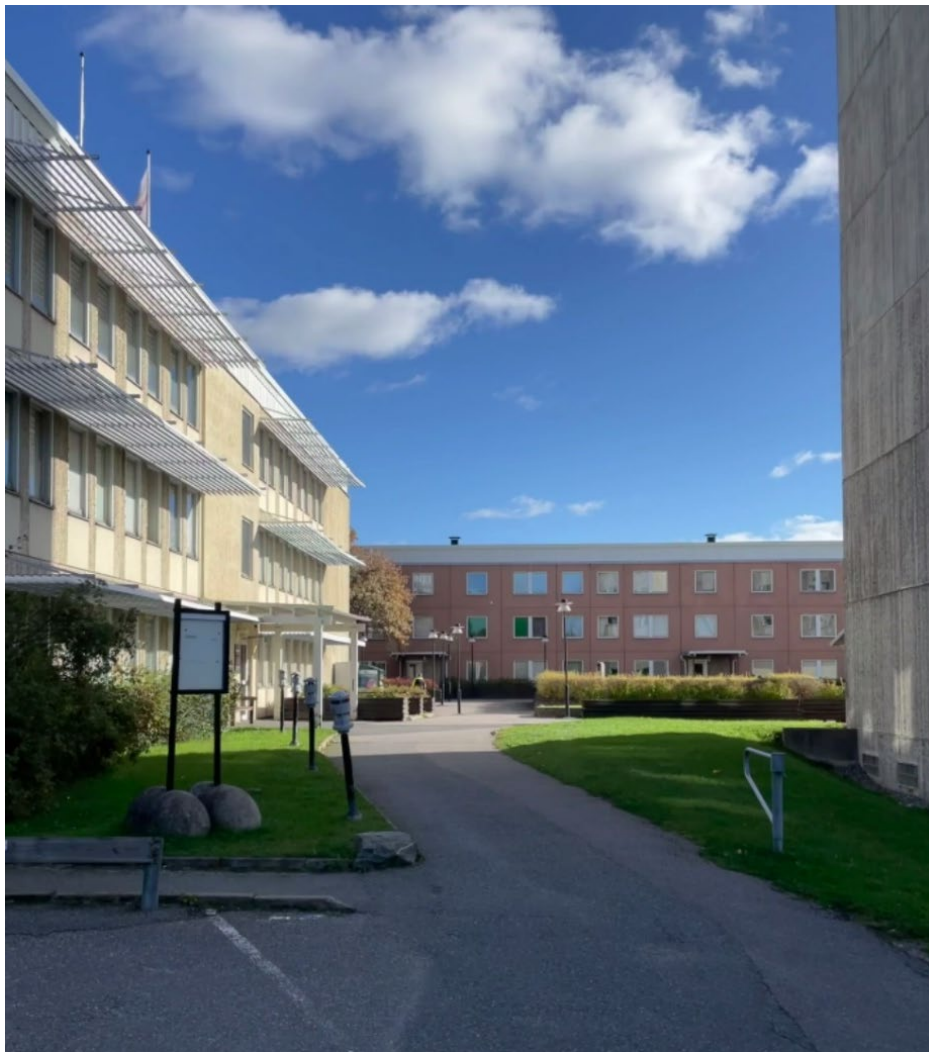
Byggnader inom Nyponet 2 (vänster) och Nyponet 3 (rakt fram & höger)
