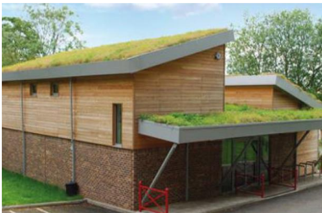
Figur 5. Sedumtak kan anläggas både på platta och lutande tak (Svenska Naturtak AB, 2017).
