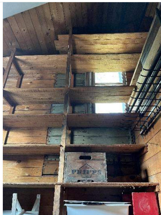
Fönster mot väster sett från insidan. Igenbyggd tidigare dörröppning till vinden.
