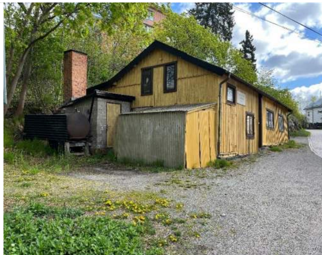
Fasad mot väster.
