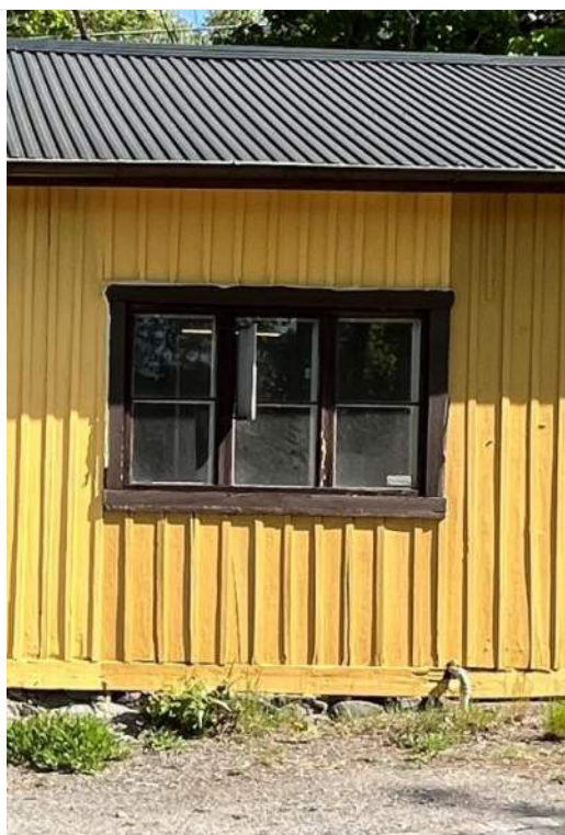
Fasad mot söder. Fönster mot verkstad (västra).
