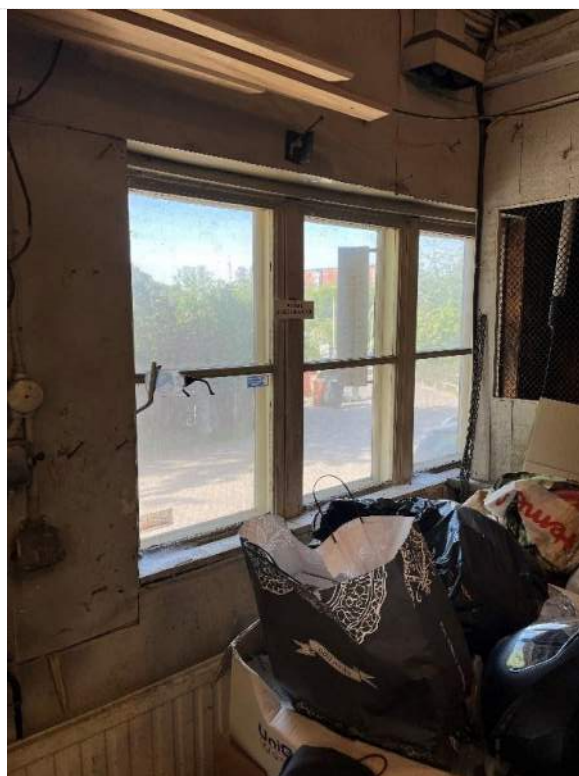
Fönster mot söder i verkstad (västra) sett inifrån. Tre separata innerbågar.
