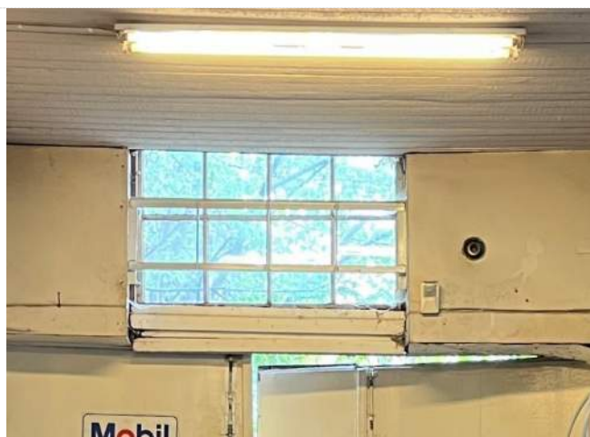
Fönster mot söder i verkstad (östra) sett inifrån. Två separata innerbågar.
