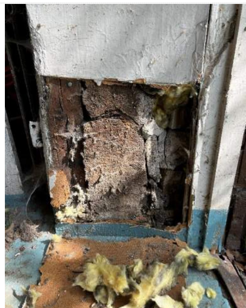
Garageport. Demonterad inklädnad med timmerstommen synlig.
