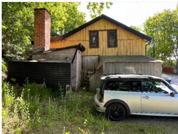
Fasad mot väster. Fönster mot verkstad, delvis igensatt med skiva och ventilationsdon.
