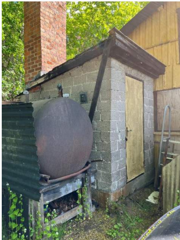
Pannrum från 1955, sedd från sydväst. Gjuten golvplatta av betong, väggar murade troligen av lättbetong.
