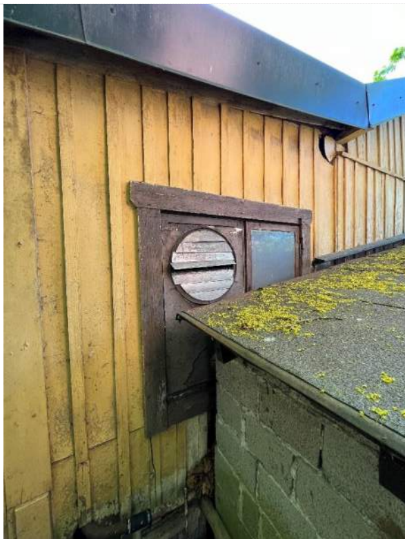
Fasad mot väster. Fönster mot verkstad, delvis igensatt med skiva och ventilationsdon.
