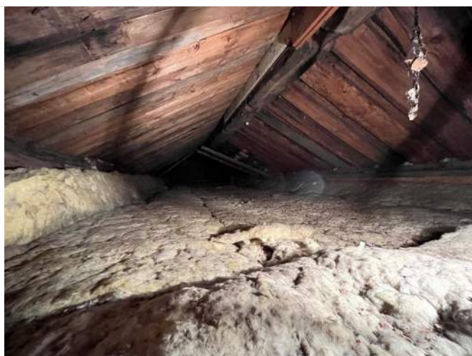
Vind 1700-talsdel. Äldre faltak mot söder (höger i bild).
