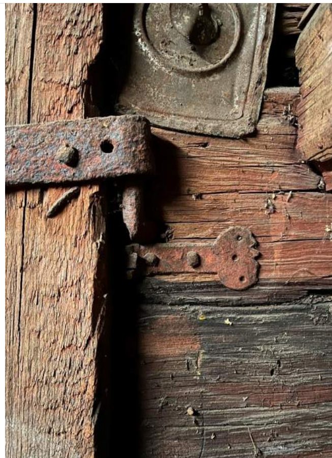
Detalj gångjärn dörr/vindslucka. Sannolikt 1790-tal eller flyttat från äldre byggnad.
