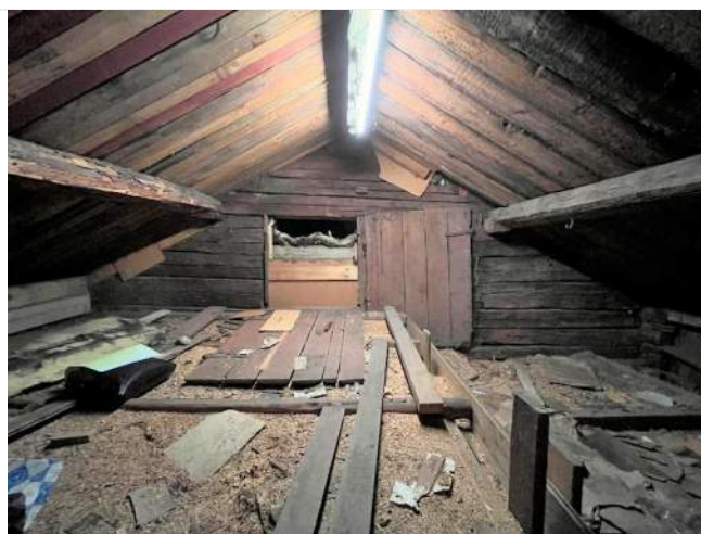
Vind 1800-talsdel, gavel 1700-tal. Södra takfallet (höger i bild) äldre faltak. Norra takfallet nyare brädor/råspont.
