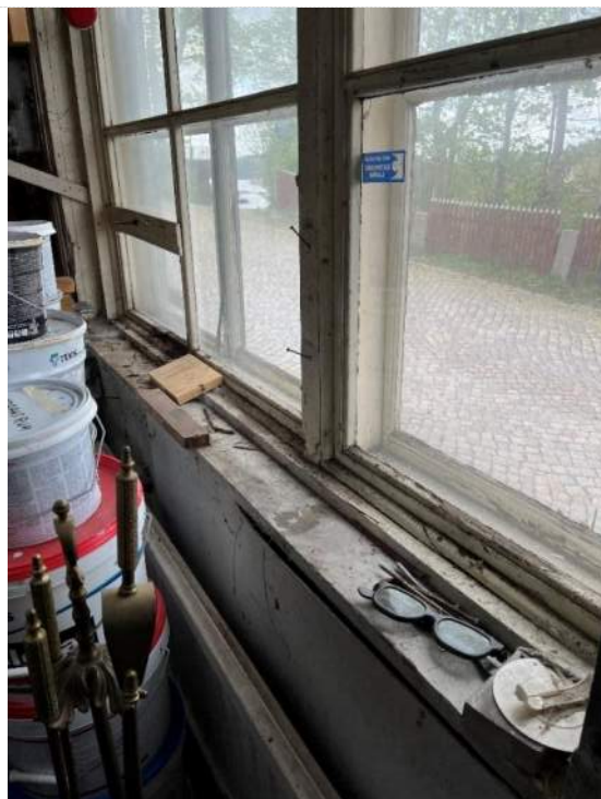
Fönster mot söder i verkstad (östra) sett inifrån. Två separata innerbågar.
