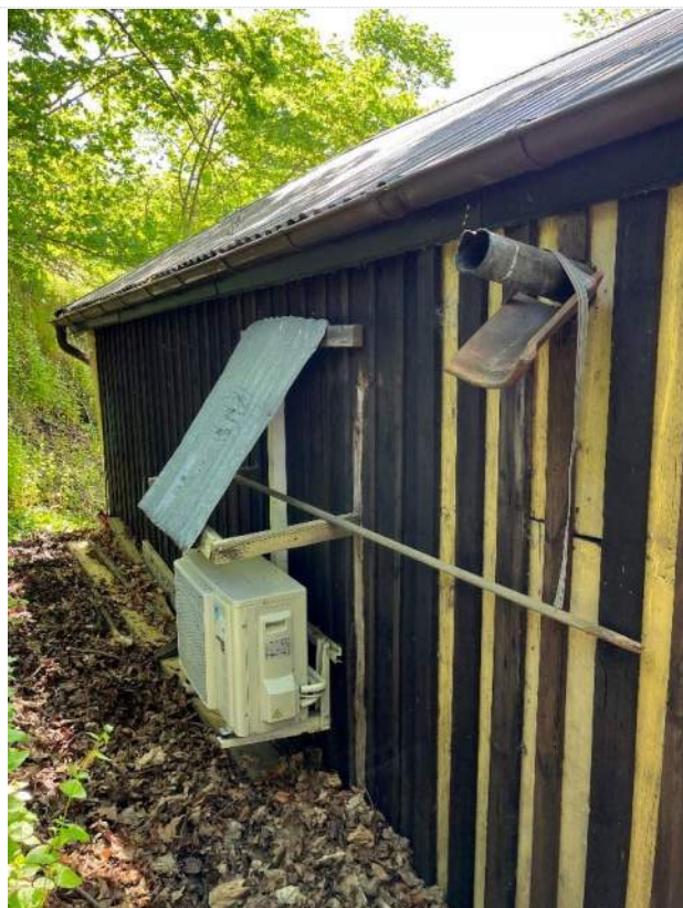
Fasad mot norr. Delvis utbytt panel.
