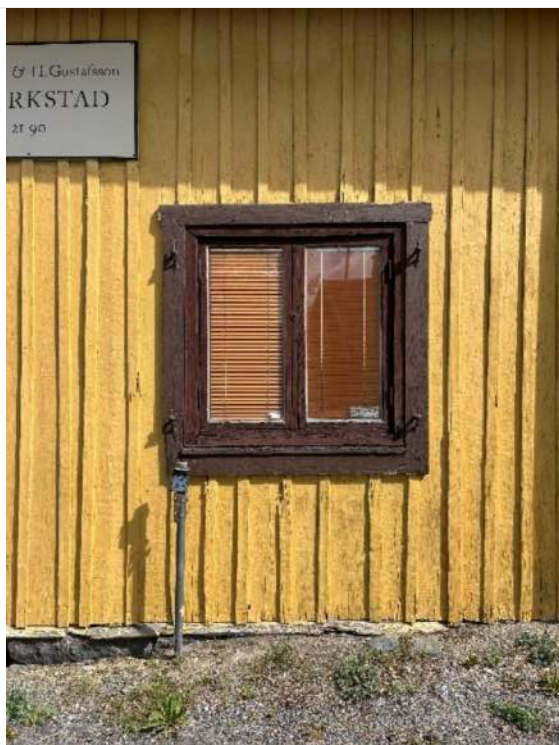
Fasad mot söder. Fönster mot kontor. Fönsterfoder och beslag från fönsterluckor från 1880-tal.
