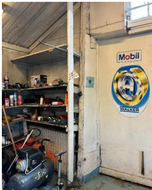
Garageport. Stor öppning är gjord i timmerstommen. Förstärkt med stående virke på in- och utsida.
