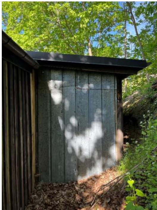
Gavel mot öster, 1940-talets tillbyggnad klädd med pannplåt. Likartade problem med förhöjd marknivå och fukt.
