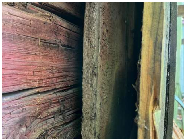
Ursprunglig rödfärgad timmerstomme med 2 lager panel, fasad mot norr.
