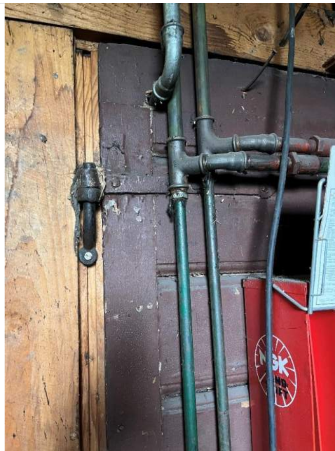
Äldre igensatt dörr mellan lager och bilverkstad.
