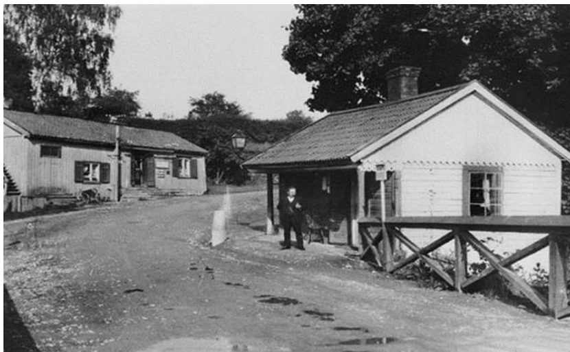
Byggnaden fungerar som handelsbod. Foto 1911
