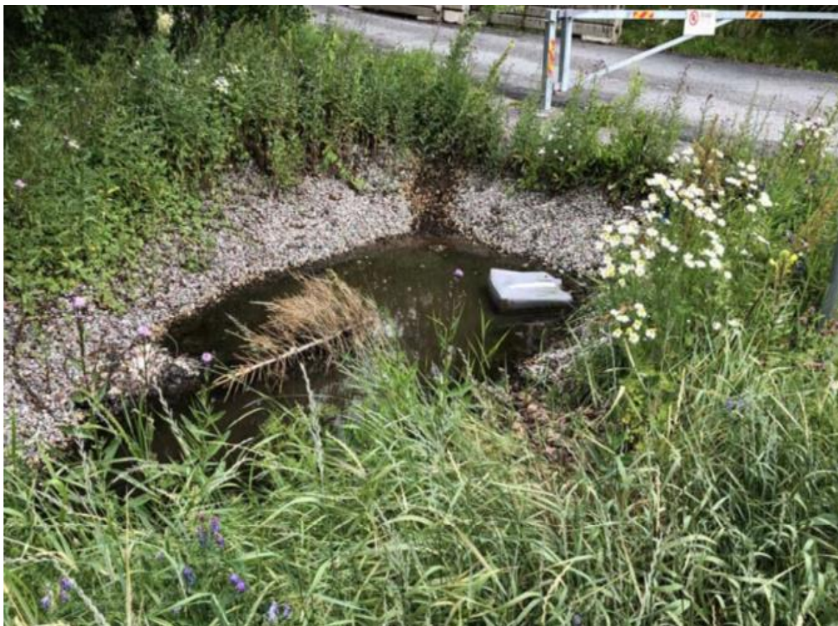
Figur 33. Smältvatten damm för kommunens snöupplag.
