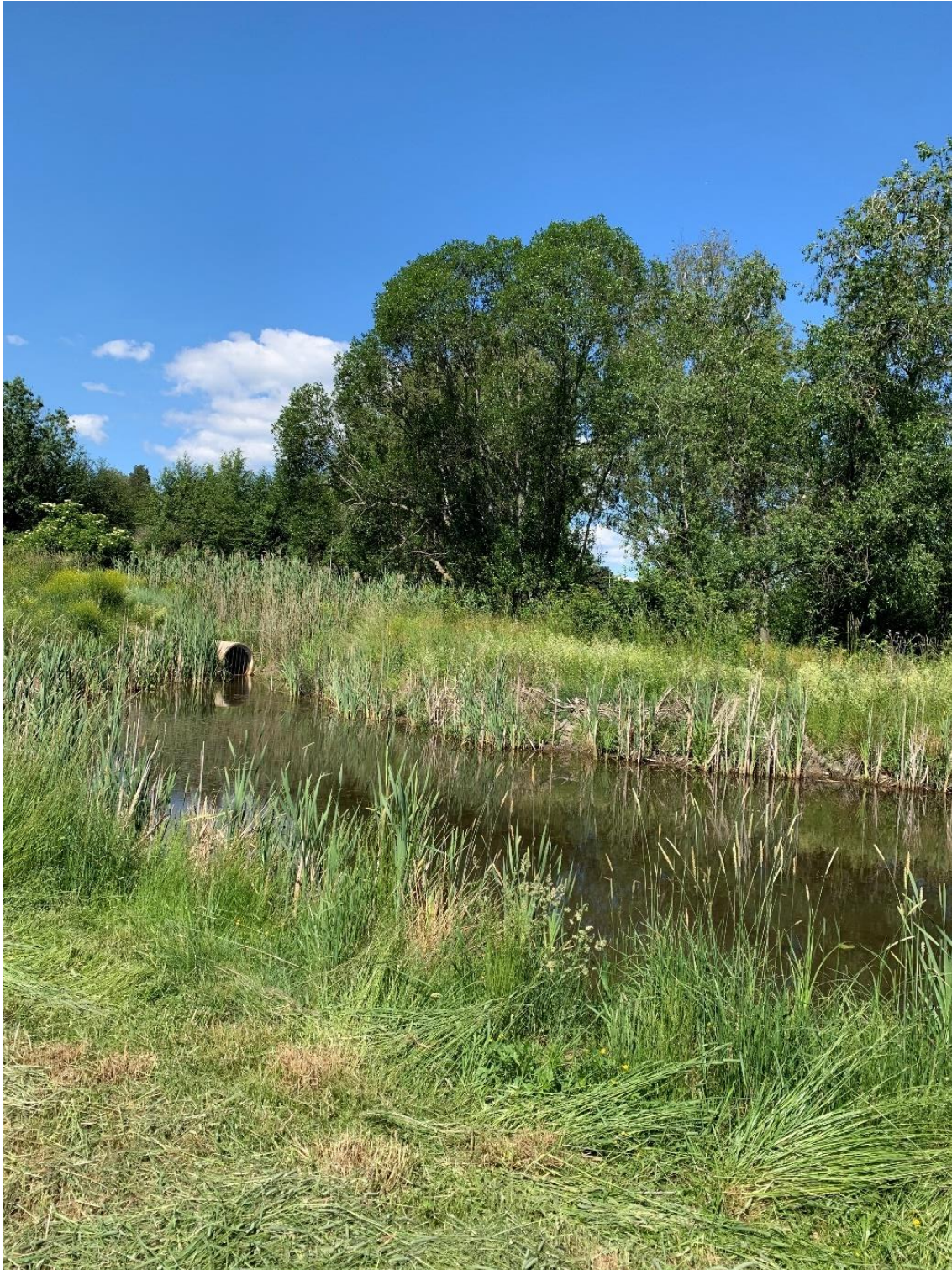
Figur 32. Angantyrdammens utlopp. Angantyrdammen renar dagvatten och förhindrar att sediment följer med in i ledningsnätet.
