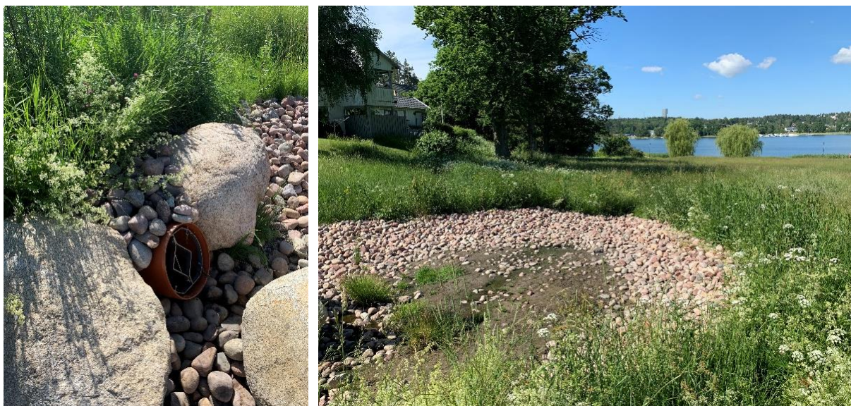
Figur 31. Dagvattenutsläppet vid Sättra Ängar.
