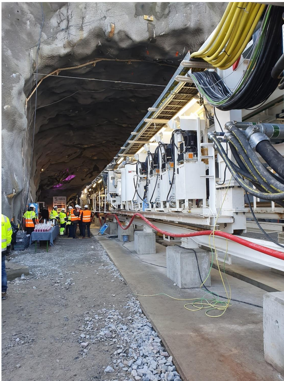
Bild ovan: Kraftledningstunnel.
