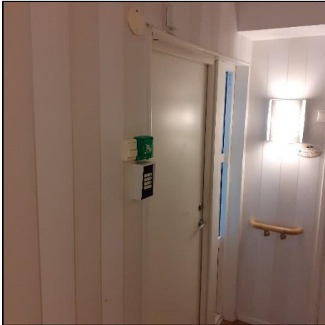
Åtgärds punkt 6. Montera två nya utrymningsarmaturer som pekar mot korridoren (se brandcellritning nedan)
