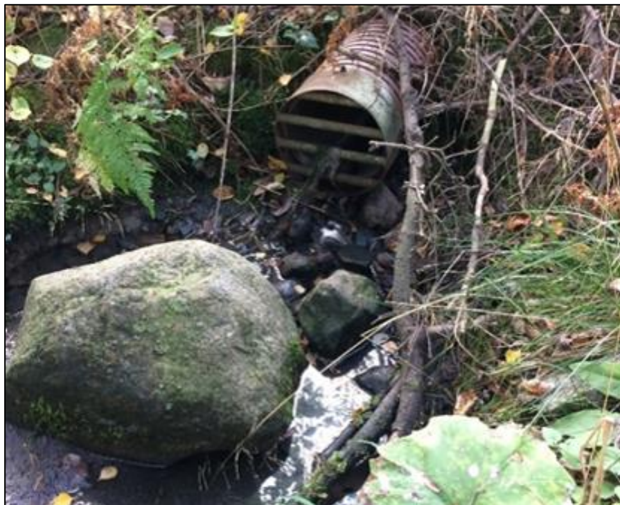
Figur 2-1. Dagvattenledning, från en av grannfastigheterna, som nedströms leds i dike genom utredningsområdet.
