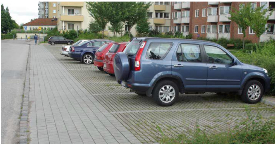
Figur 21. Exempel på parkering med genomsläpplig beläggning. Foto WRS AB.
