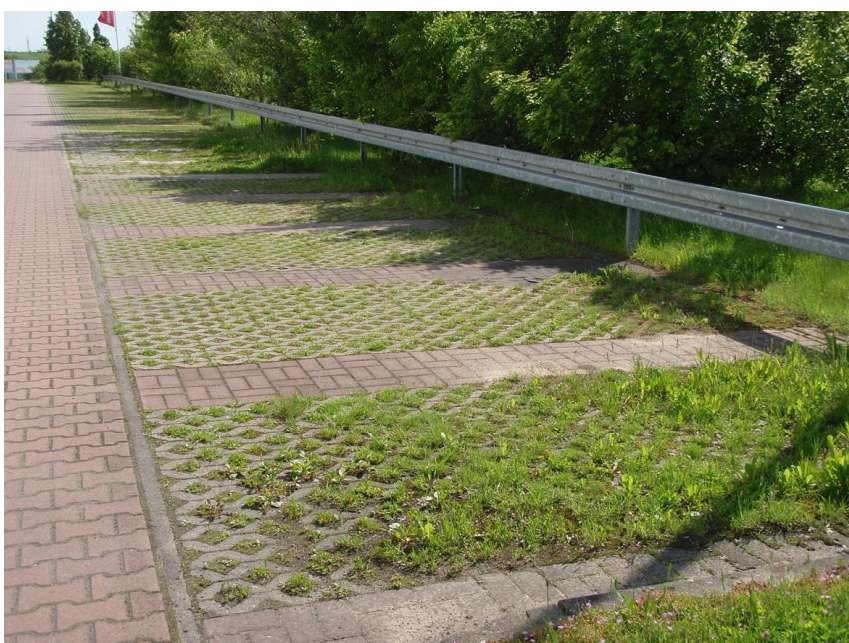
Figur 22. Infiltrerbara, gröna parkeringsplatser utformade med betonghålsten.
