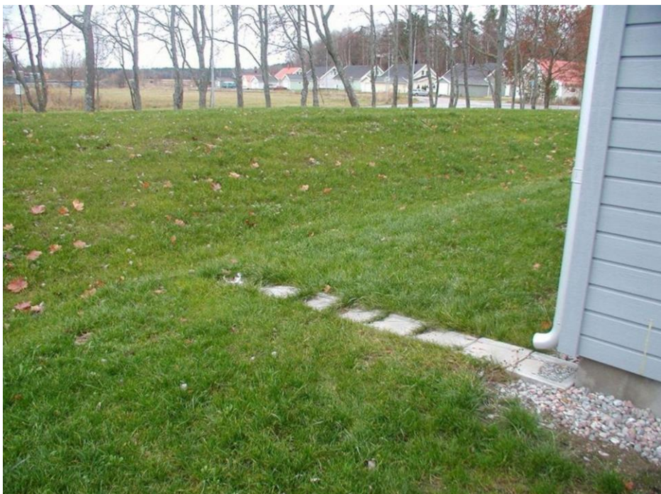
Figur 16. Utkastare och rännadalsten som avleder vattnet bort från byggnaden till gräsbevuxen yta.
