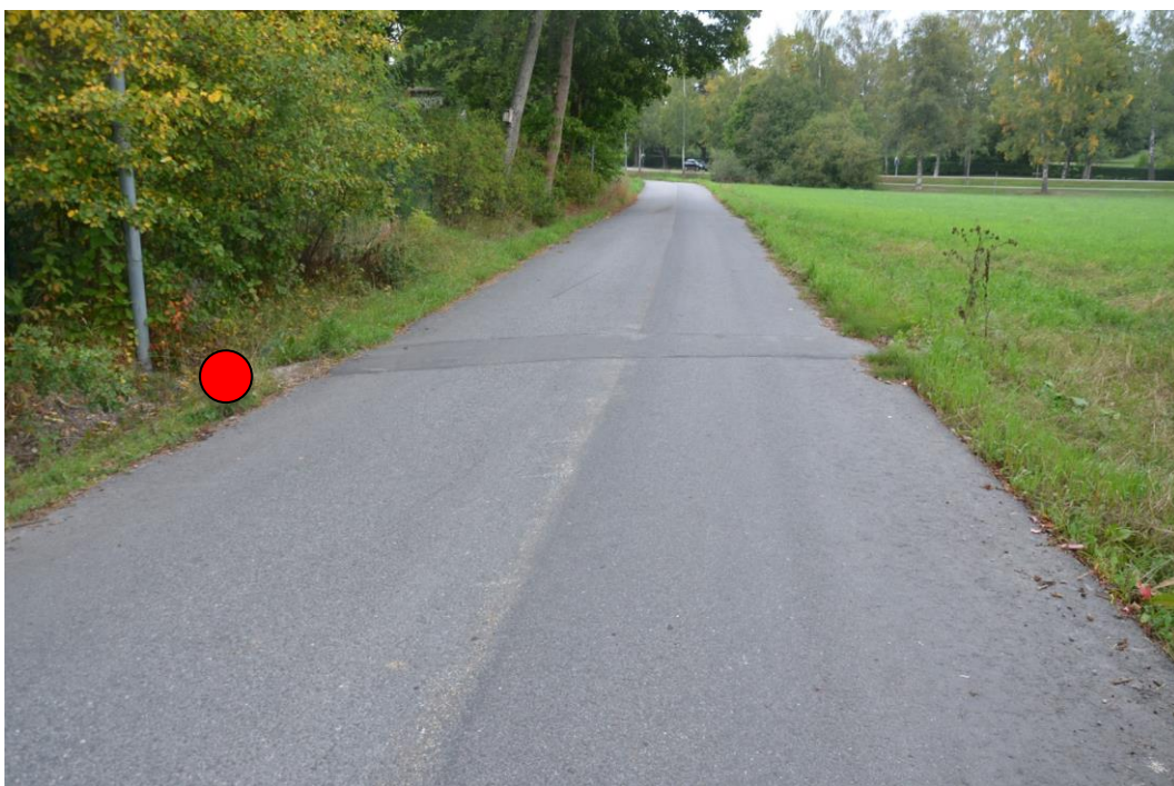
Figur 6. Ledning under Parkstigen för vatten att kommunicera mellan södra sidan och norra sidan mot planområdet. Röd punkt markerar ledningens placering.
