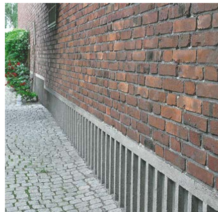
Sockel, en del av fasaden. Räfflad betongsockel möter tegelfasad. Gymnastik- och idrottshögskolan
