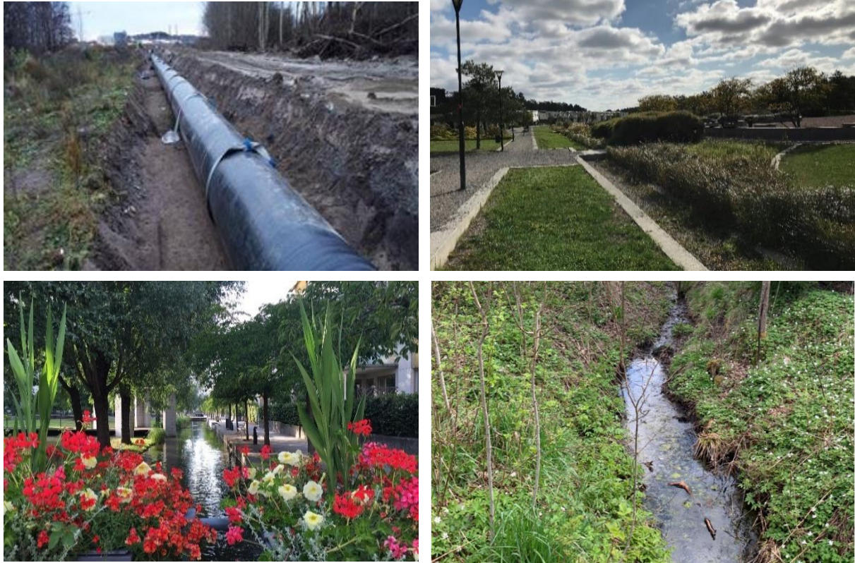
Figur 4. Avledning av dagvatten kan ske via ledningsnät, diken och öppna blå-gröna dagvattenstråk (Foto: Bjerking).
