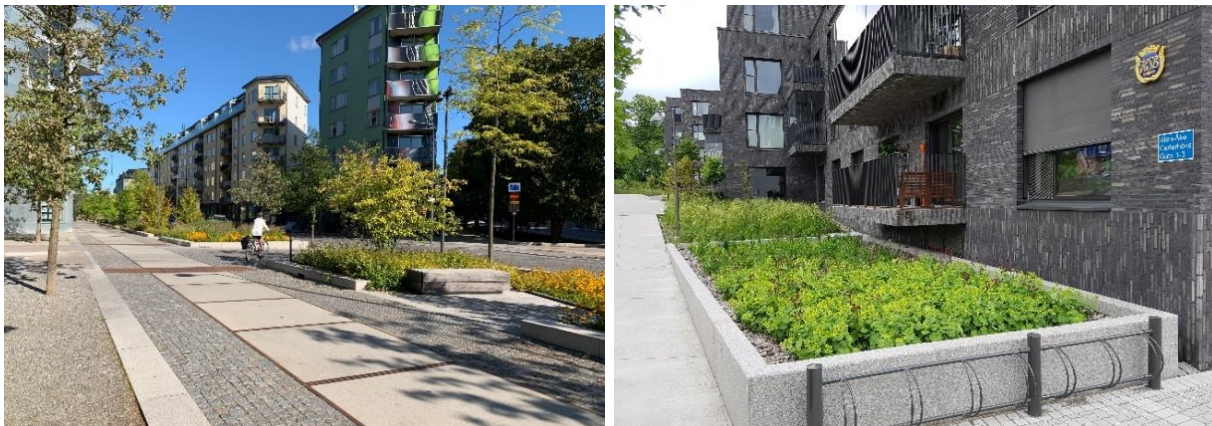
Figur 3. Exempel på lokala dagvattenlösningar med växtbäddar på allmän platsmark och på kvartersmark i Norra Djurgårdsskogen i Stockholm och i Göteborg (Foto: Bjerking).
