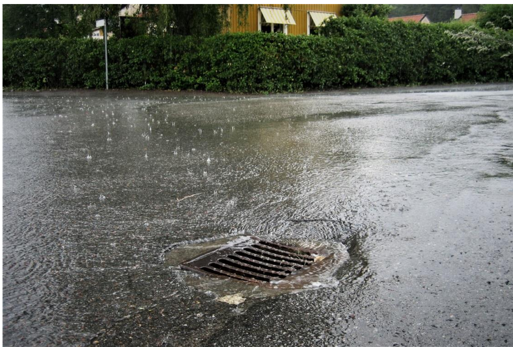
Bild ovan: Regnvatten i dagvattenbrunn.
