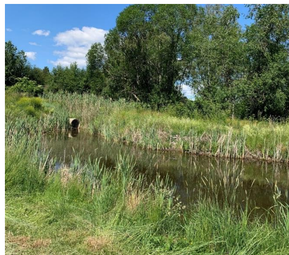
Figur 50. Angantyrdammens utlopp. Angantyrdammen renar dagvatten och förhindrar sediment att följa med in i ledningsnätet (Foto: Danderyds kommun).
