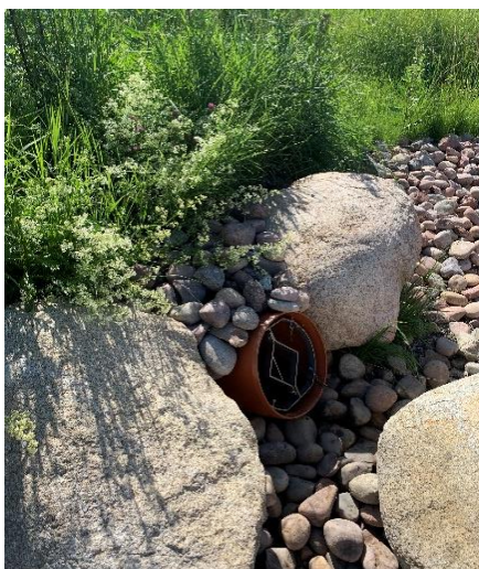
Figur 49. Dagvattenutsläppet vid Sätra Ängar (Foto: Bjerking).
