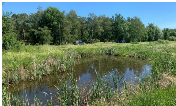
Figur 5. Dagvatten kan omhändertas i större nedströms dagvattenlösningar som dammar. Foto från Angantyrdammen i Danderyd. (Foto: Bjerking).
