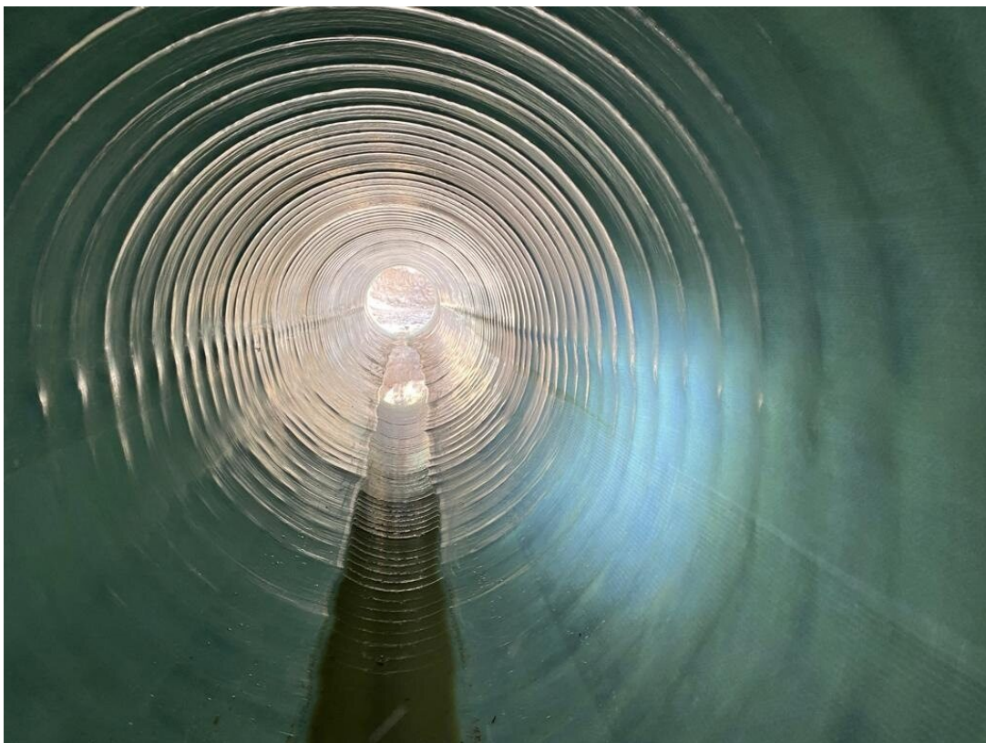
Figur 1, Renoverad dagvattenledning, Nora torg Fotograf: Simon Åkerlund
