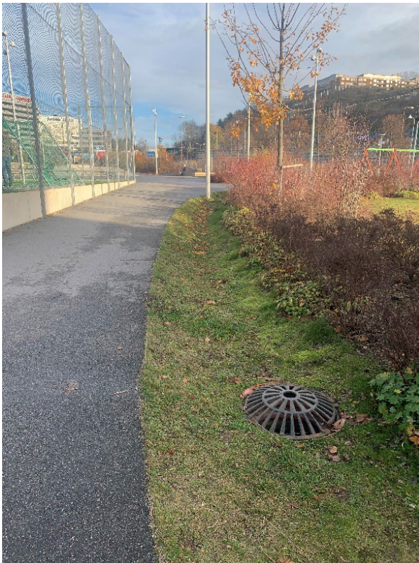
Figur 9. Infiltrationsstråk har en god förmåga att rena dagvatten. Infiltrationsstråken förses ofta med en brunn som placeras över stråkets botten. Exempelbilder från Stockholm och Hammarby sjöstad. (Foto: Bjerking).
