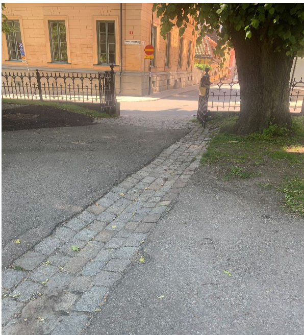
Figur 15. Exempelbilder på stuprörsutkastare och ränn dalar från Stockholm och Malmö. (Foto: Bjerking).
