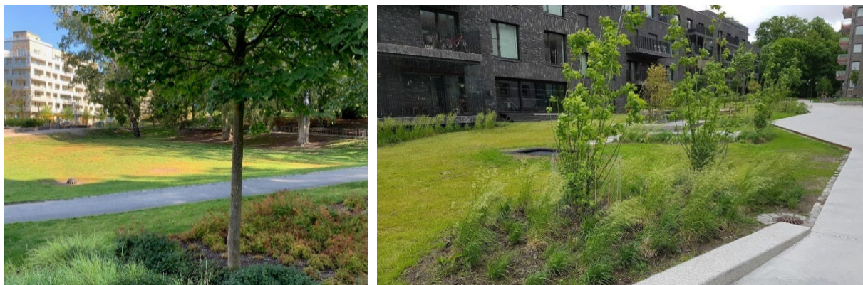
Figur 13. Infiltration i grönyta bidrar till rening, fördröjning och infiltration till grundvatten men är en ytkrävande åtgärd. Exempelbilder från Stockholm och Göteborg. (Foto: Bjerking).
