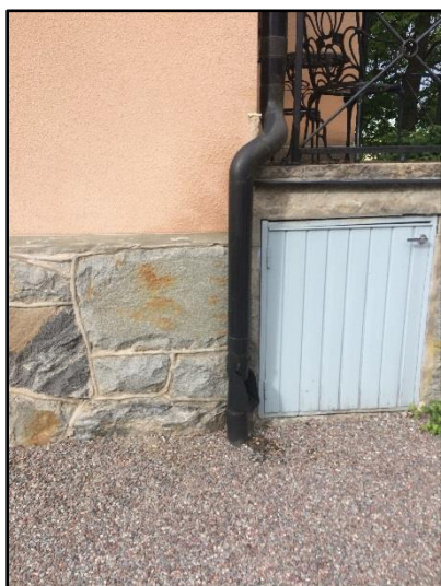
Bild 6. Stuprör för takavvattning av befintligt bostadshus.
