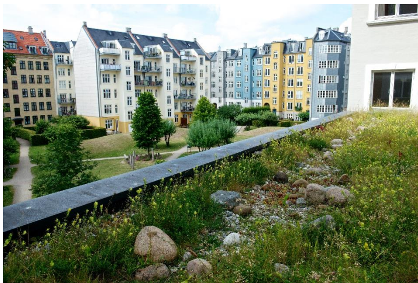
Figur 13. Grönt tak och grön innergård (Foto: Vegtech).
