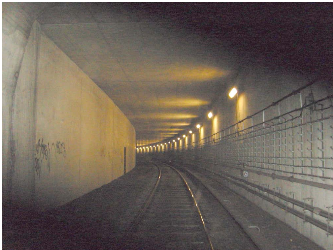
Bild 3. Vybild inifrån tunneln. Bilden är tagen mot norr i södergående spår. Från förvaltningssystemet BATMan.
