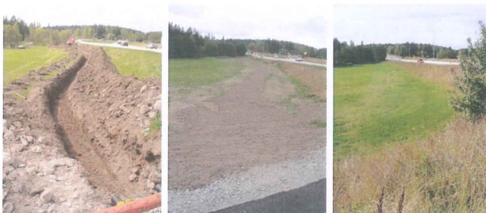
Figur 4. Öppet kabelschakt. Arbetsområdet efter återställning. Efter två växtsäsonger.
