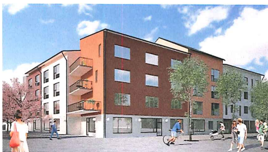
Sigtuna Stadsängar äldreboende och trygghetsboende, Sigtuna. Byggstart 2017
