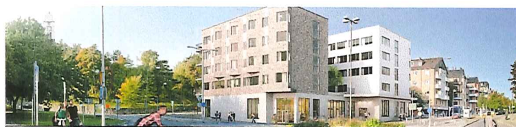
Tule Plaza äldreboende, Sundbyberg. Under produktion, färdigställt 2018
