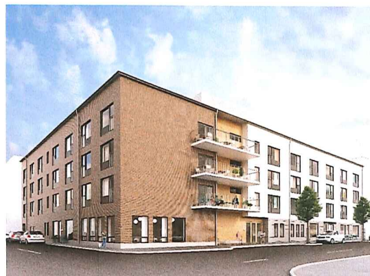
Halmstad Plaza äldreboende, Halmstad. Färdigställt 2015
