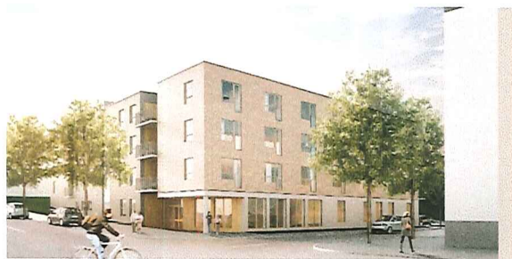
Riksten Plaza äldreboende, Botkyrka. Färdigställt 2016
