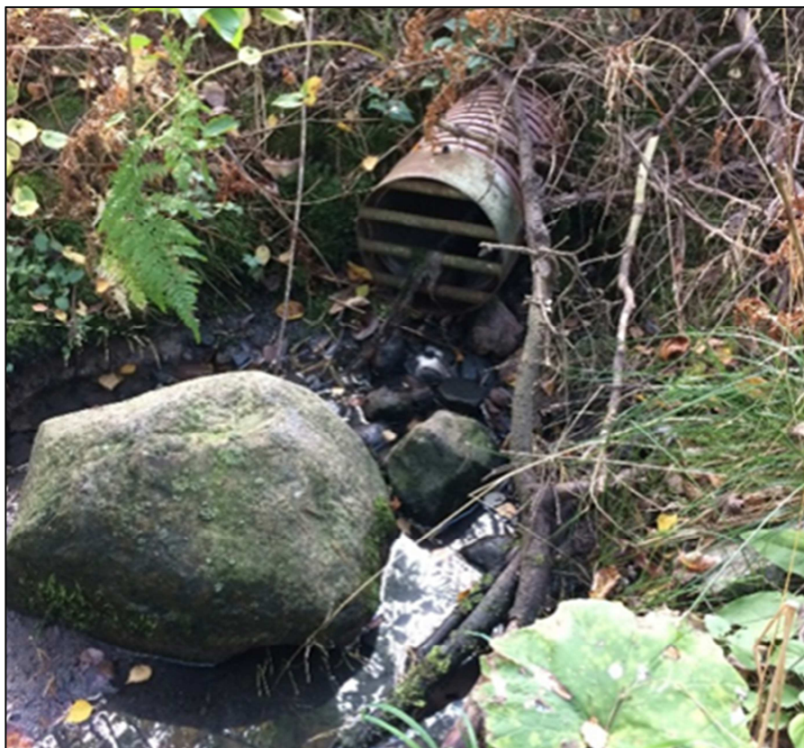
Figur 2-1. Dagvattenledning, från en av grannfastigheterna, som nedströms leds i dike genom utredningsområdet.
