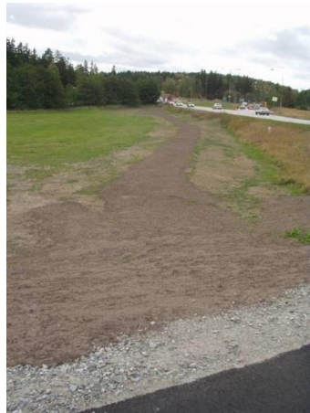
Arbetsområdet efter återställning
