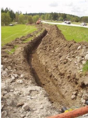
Figur 4.3. Öppet kabelschakt
