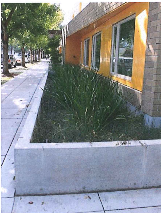
Figur 8. Exempel på växtbädd. Observera att växtbäddar kan anläggas utan något behov av mur runt omkring. Foto: WRS
