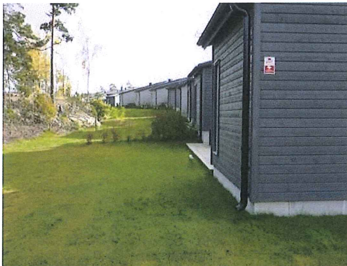
Figur 7. Stuprör med utkastare mot grönytan. Vattnet kan infiltrera i grönytan och vid större flöden avleds vattnet ytledes mot ett svackdike som även avvattnar området vid extrema situationer (t.v. i bild). OBS! På fotot saknas tät avledning från husliv de
