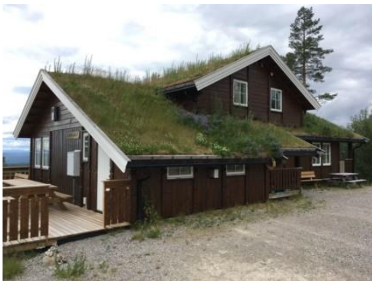
Figur 6. Exempel på tjockt grönt tak. Foto: WRS
