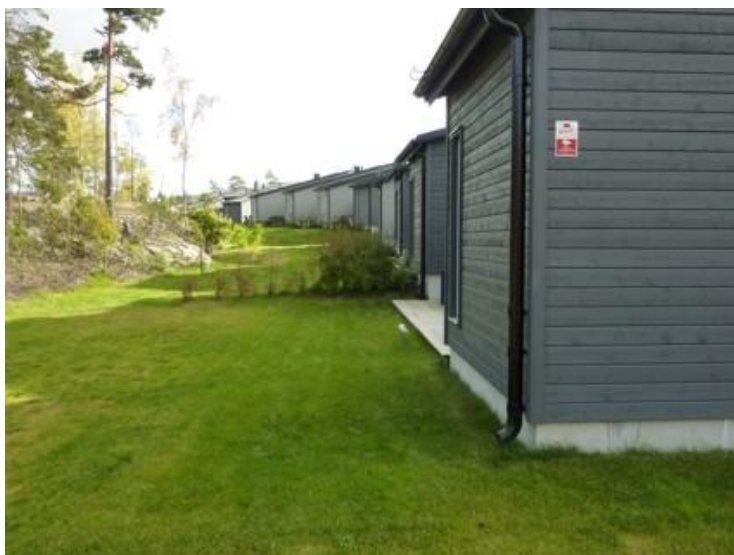
Figur 7. Stuprör med utkastare mot grönytan. Vattnet kan infiltrera i grönytan och vid större flöden avleds vattnet ytledes mot ett svackdike som även avvattnar området vid extrema situationer (t.v. i bild). OBS! På fotot saknas tät avledning från husliva de
