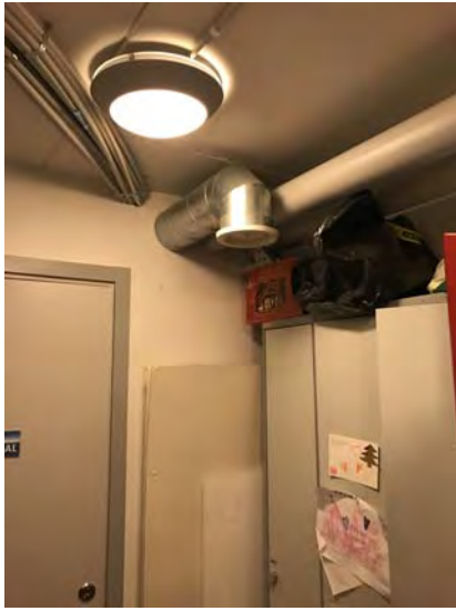
09. Elinstallation + ventilation i omklädnad.
