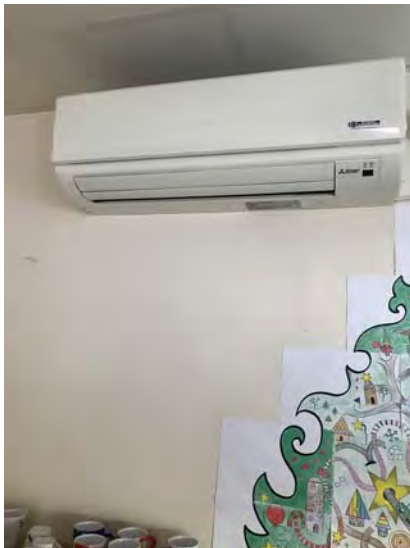
09. Inomhusdel uteluftsvärmepump.
