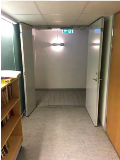
07. Vägledande maktöring syns ej då dörren stängs vid brand.
