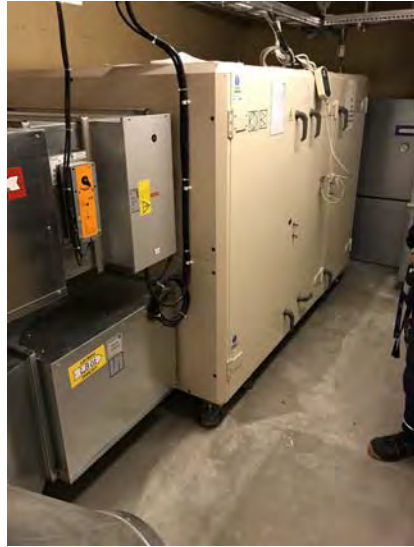
14. Luftbehandlingsaggregat.
