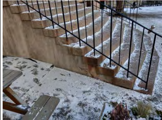
02. Sättningskador entré.
