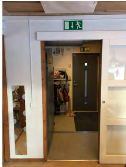
26. Efterlysande vägledande markeringar inom hela byggnaden
