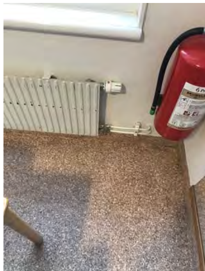
24. Kopplingsledningar i vägg.
