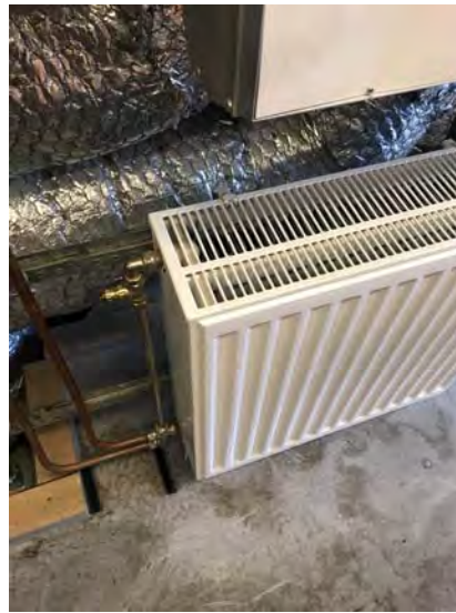
20. Radiator fläktrum, termostatdel saknas.
