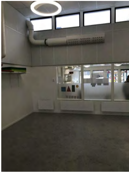
13. Nytt dysdon på gammal kanal samt elradiatorer.
