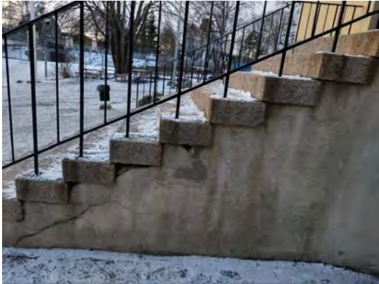
01. Sättningskador entré.
