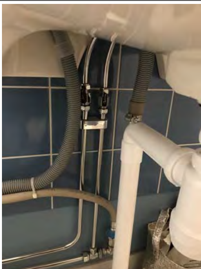
17. Tvättmaskinanslutning efter vattenlås.
