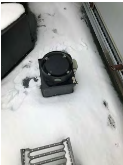
11. Frånluftsfläkt varmvattenberedning (ej i drift).
