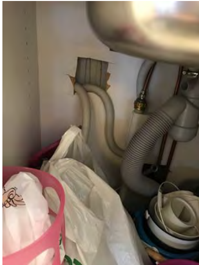
13. Diskbänksinredning. OBS radiator bakom ursparing.
