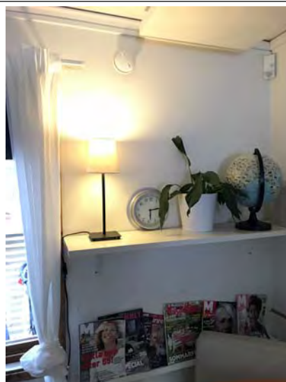
24. Uteluftsdon genom yttervägg.
