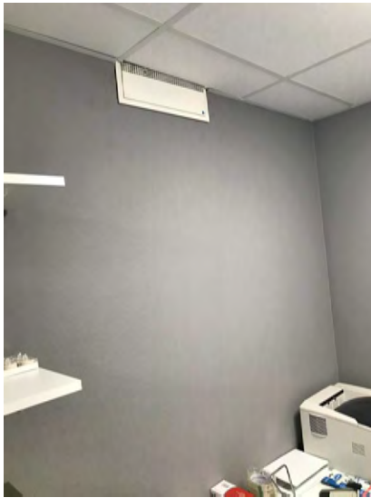
19. Tilluftsdon delvis infällt i undertak.
