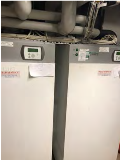
39. Bergvärmepump.
