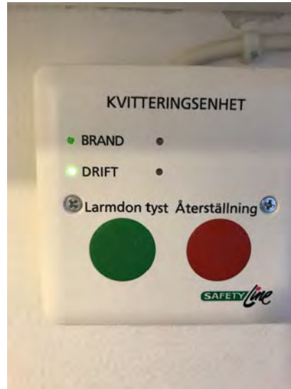
26. Kvitteringsenhet Brandlarm.
