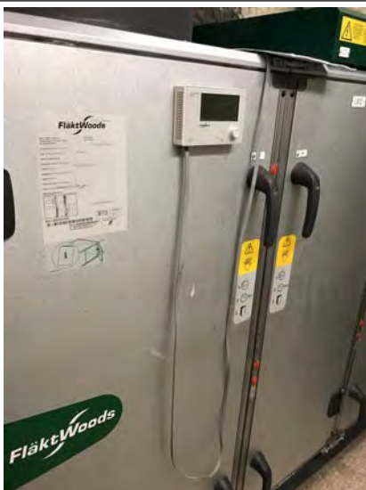
29. Luftbehandlingsaggregat.
