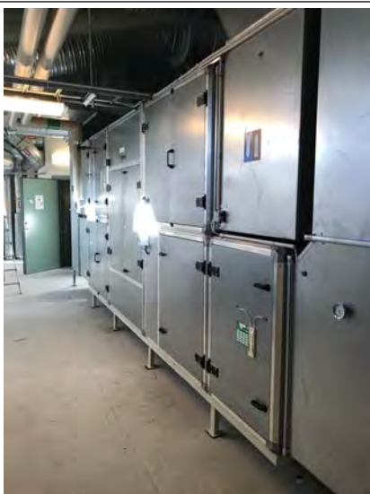
21. Luftbehandlingsaggregat.
