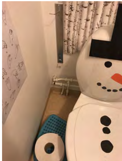
16. Rör genomföring i golv i WC.
