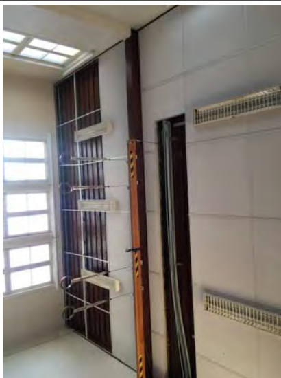
29. Träysikt tak gymnastikhall.
