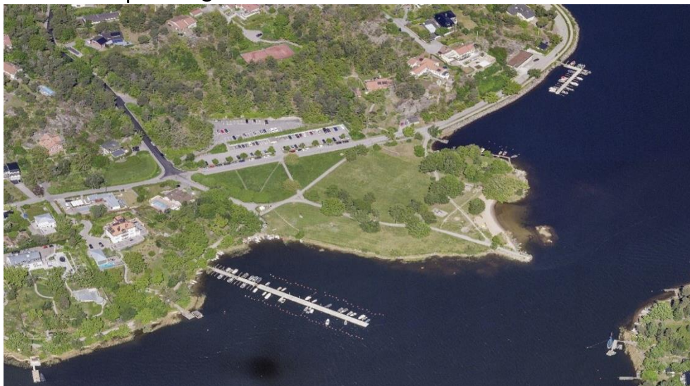
Bild ovan: Svanholmsparkeringen - Ortofoto från 2019.
