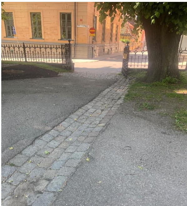
Figur 15. Exempelbilder på stuprörsutkastare och rännदारar från Stockholm och Malmö. (Foto: Bjerking).
