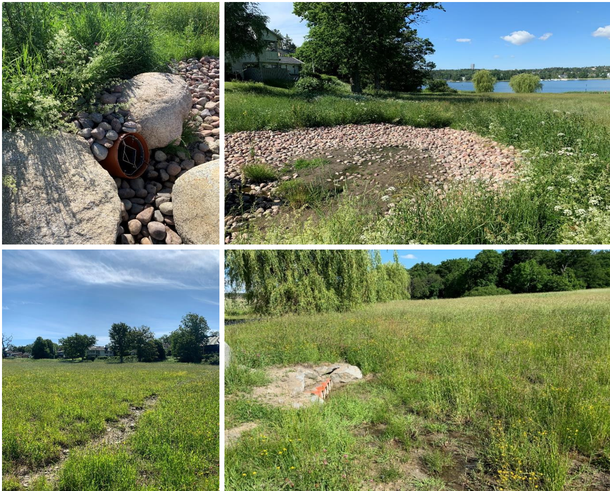
Figur 16. Vid Sättra ängar i Danderyd har en dagvattenledning öppnats upp. Vattnet tillåts nu sila över en större grönyta innan utsläpp till Edsviken (Foto: Bjerking).
