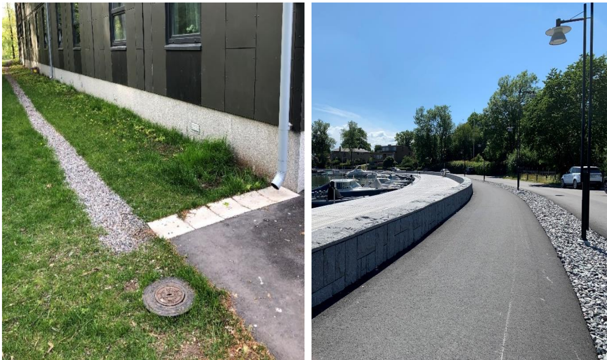
Figur 11. Makadamdiken kan anläggas både på kvartersmark samt allmän platsmark. T.V. visas fördröjning av takvatten från ett flerfamiljshus i Stockholm (Foto: Bjerking). T.H. är ett makadamdike mellan väg och gång- och cykelbana i Samsjöviken i Danderyds östra delar (Foto: Danderyds kommun).
