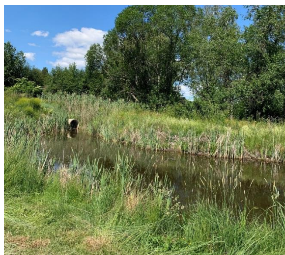
Figur 50. Angantyrdammens utlopp. Angantyrdammen renar dagvatten och förhindrar sediment att följa med in i ledningsnätet (Foto: Danderyds kommun).
