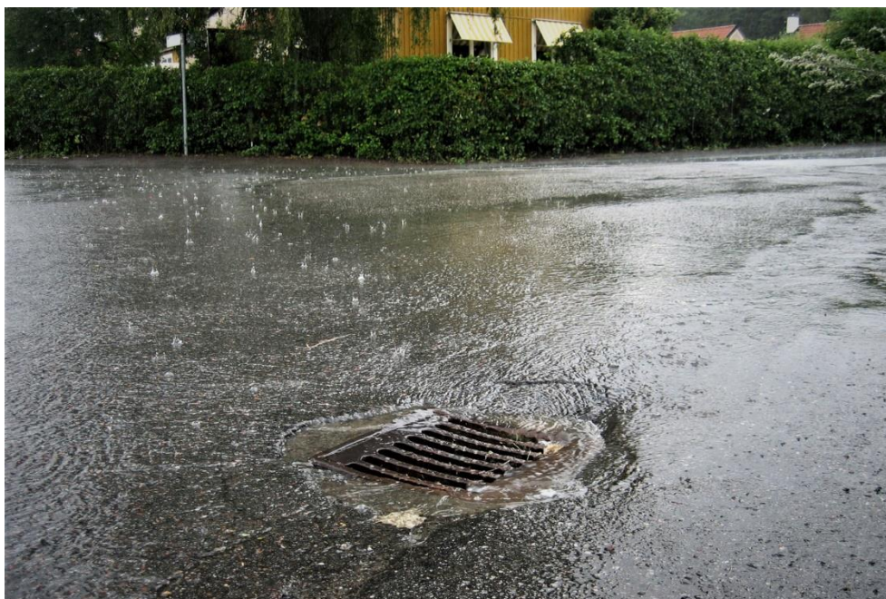
Bild ovan: Regnvatten i dagvattenbrunn.
