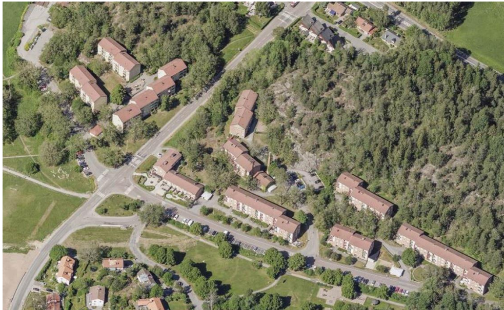
Bild ovan: Sätträängsvägen - Ortofoto från 2019.
