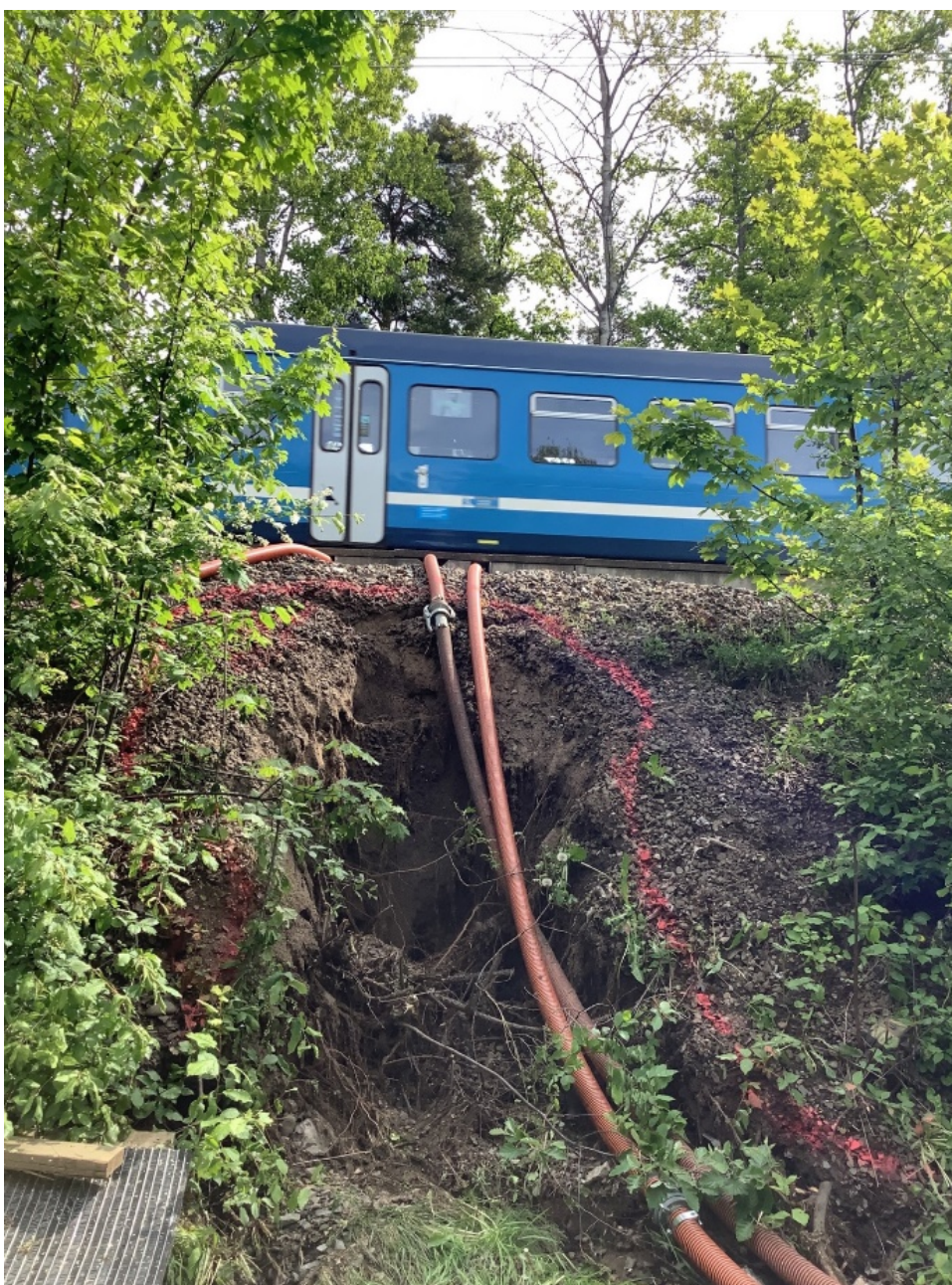
Figur 3, Underminering av räls Roslagsbanan efter ihållande regn maj 2021.
