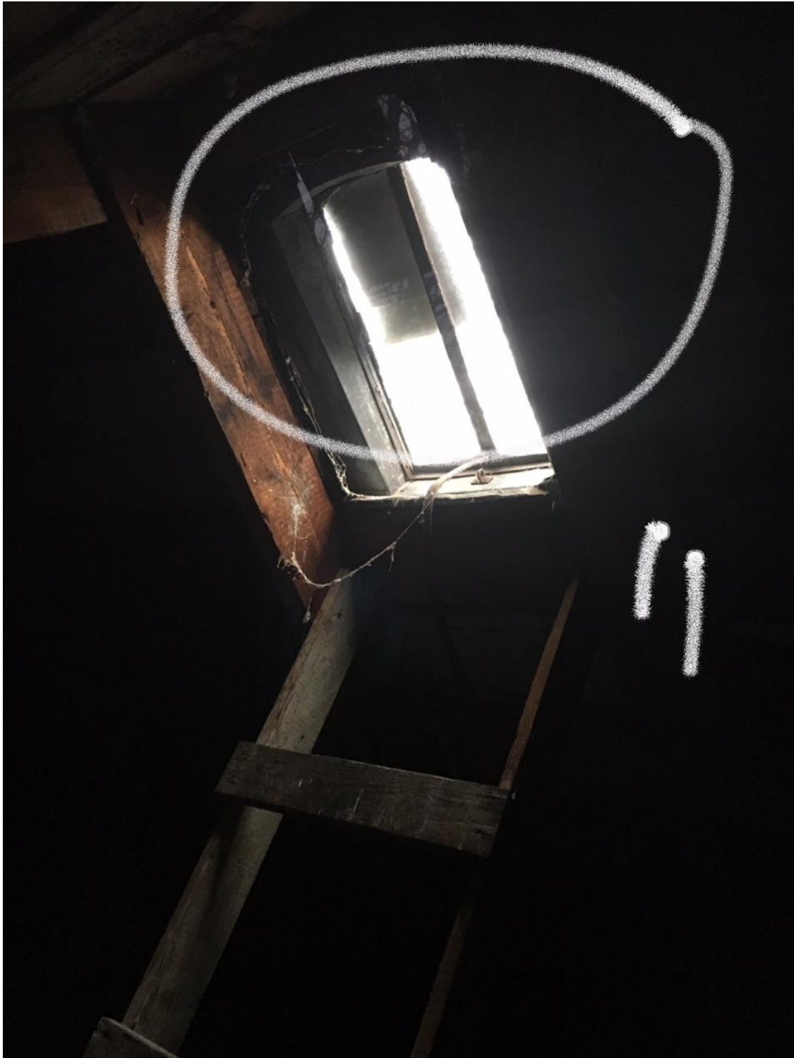
Takfönster på vind, glas borta, papp som tillfällig tätning (11)
