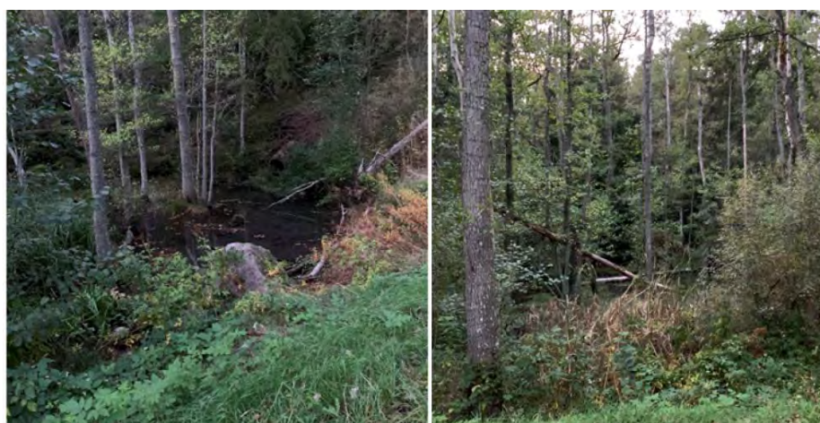
Figur 10 – Bilder från platsbesöket vid Snickartorpsdammen hösten 2020. Västra bilden visar inloppsledningen.
