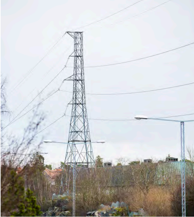
Figur 5.2 Bild över befintlig kraftledning och stolptyp
