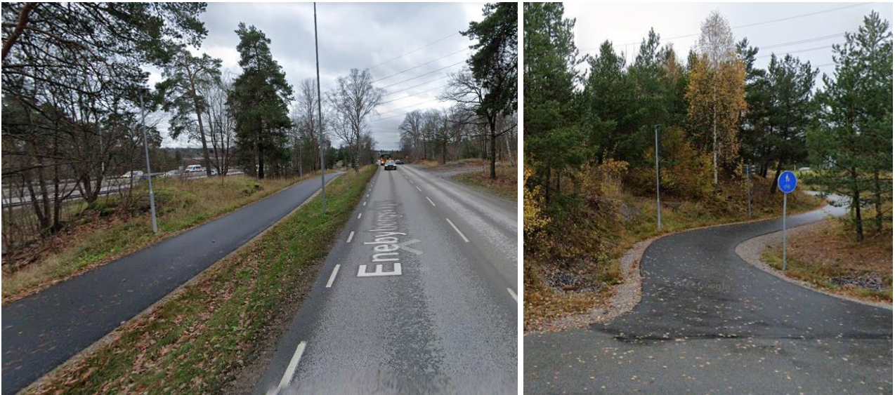
Figur 9. Gång- och cykelstråk parallellt med Enebybergsvägen och korsningen med Gymnasievägen (Google, 2022)
