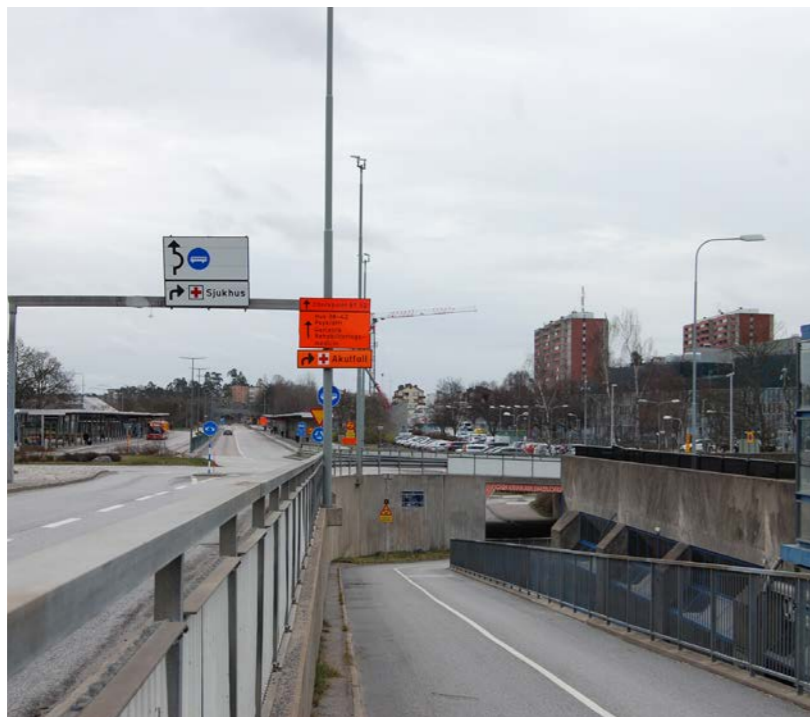
Gång- och cykelstråket längs med Mörbygårdsvägen, vy mot tunneln under Vendevägen, foto & Rundquist
