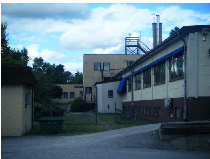
Figur 23. Industribyggnaden på Bromsen 11 innan ny exploatering.
