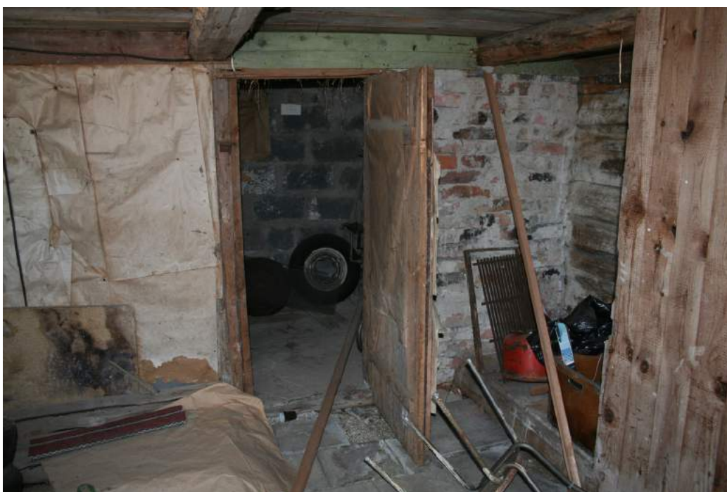
Bild 35. Friliggande timmerstomme, murade innerväggar. Innerväggarna har tätats med papper
