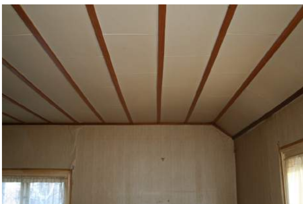
Bild 30. Det östra rummet - plattor sitter på innertaket, fasthållna av trälistor. På väggarna en stråtapet
