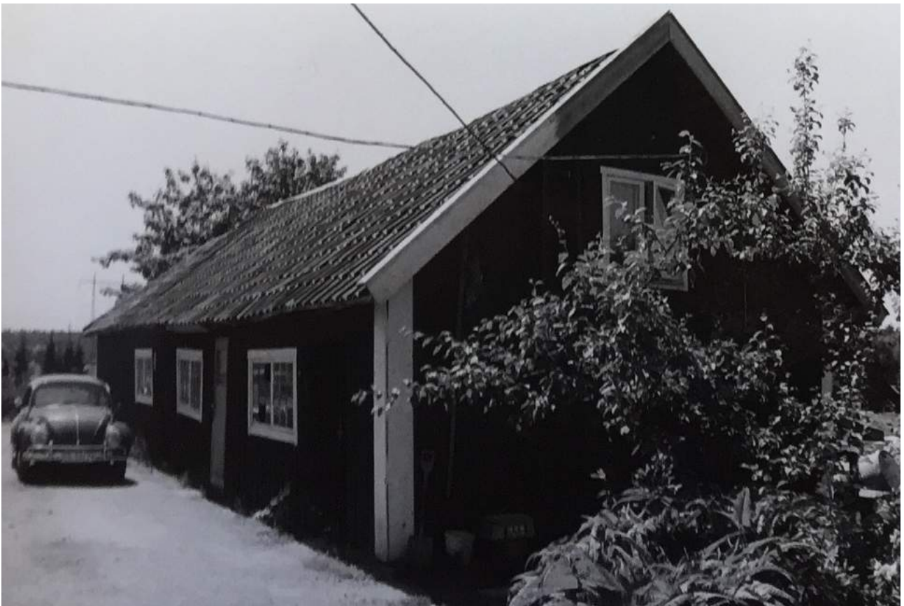
Bild 16. Foto från byggnadsinventeringen, benämnt "stallet från norr"
