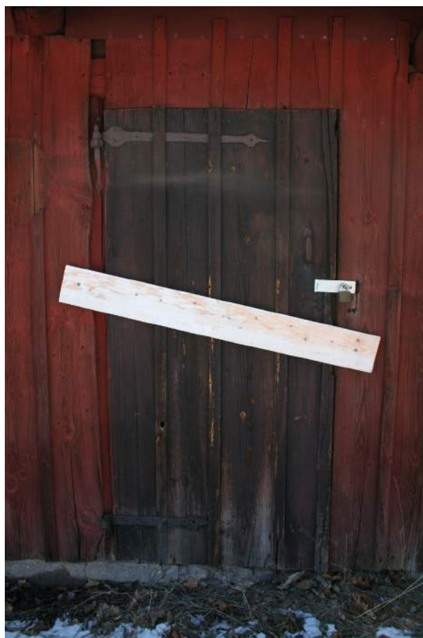
Bild 34. Plankdörr av breda plank och ett bandgångjärn av typen som uppträder under 1700-talets andra halva.
