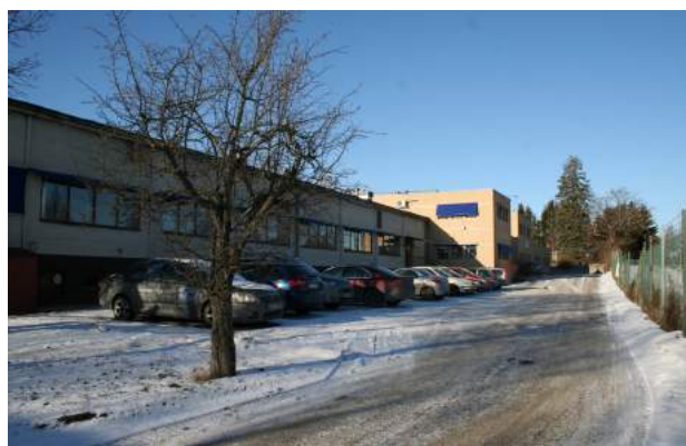
Bild 10. Verksamhetsbyggnaden, fasad mot Täbyvägen/öster
